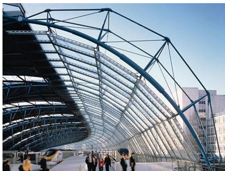
Figure 16. Toiture de la gare de Waterloo par Grimshaw ( https://grimshaw.global/ , consulté le 31/05/22)
