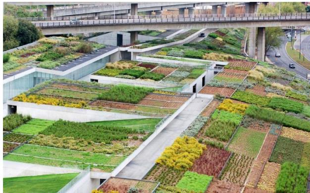
**Figure 14 - Toiture intensive comprenant différentes variétés de plantes sur la station de traitement des eaux Alcântara à Lisbonne au Portugal, (efb-greenroof.eu,2011)**
