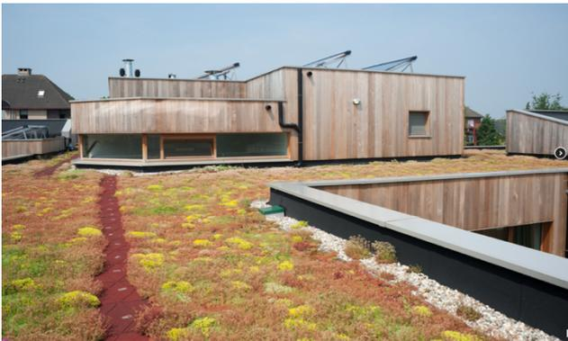
**Figure 12 - Mousses et sédums sur une toiture verte végétalisée, (guidebatimentdurable.brussels, s.d.)**
