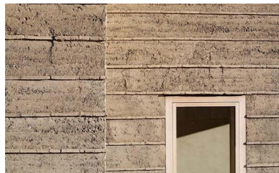
Figure 5 : Réalisation en béton damé (source : actu.epfl.ch)
