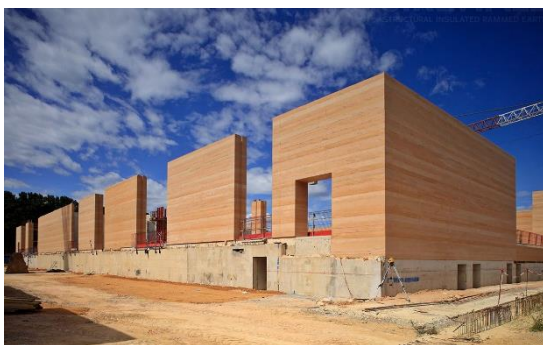
Figure 4 : Réalisation en terre damée stabilisée (source : narbovia.fr)
