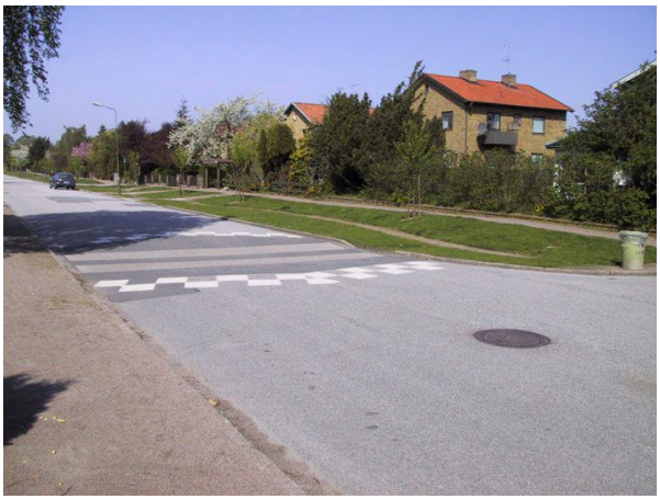
Figure n°13 Une installation intégrée de circulation et de drainage à Vanasgatan à Malmö. Source : Stahre P. 15 Years Experiences of Sustainable Urban Storm Drainage in the City of Malmo, Sweden. 2005.
