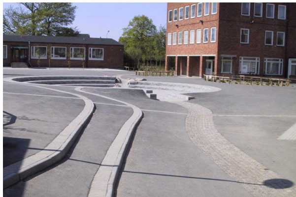
Figure n°11 Un amphithéâtre pour la rétention des eaux pluviales d'une cour d'école. Source : Stahre P. 15 Years Experiences of Sustainable Urban Storm Drainage in the City of Malmo, Sweden. 2005.
