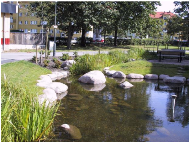
Figure n°12 Un parc intégré et un couloir de drainage à Långgatan à Malmö. Source : Stahre P. 15 Years Experiences of Sustainable Urban Storm Drainage in the City of Malmo, Sweden. 2005.
