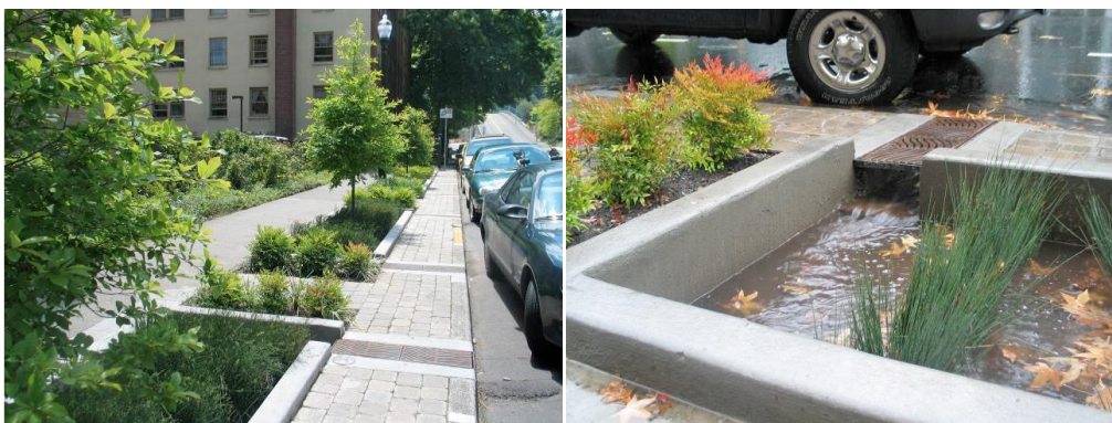
Figure n°9 Illustration des rues vertes du projet « SW 12th and Montgomery Green Street Stormwater Planters » . Source : St, Sw. Harrison. Green Infrastructure Tour, 2012.
