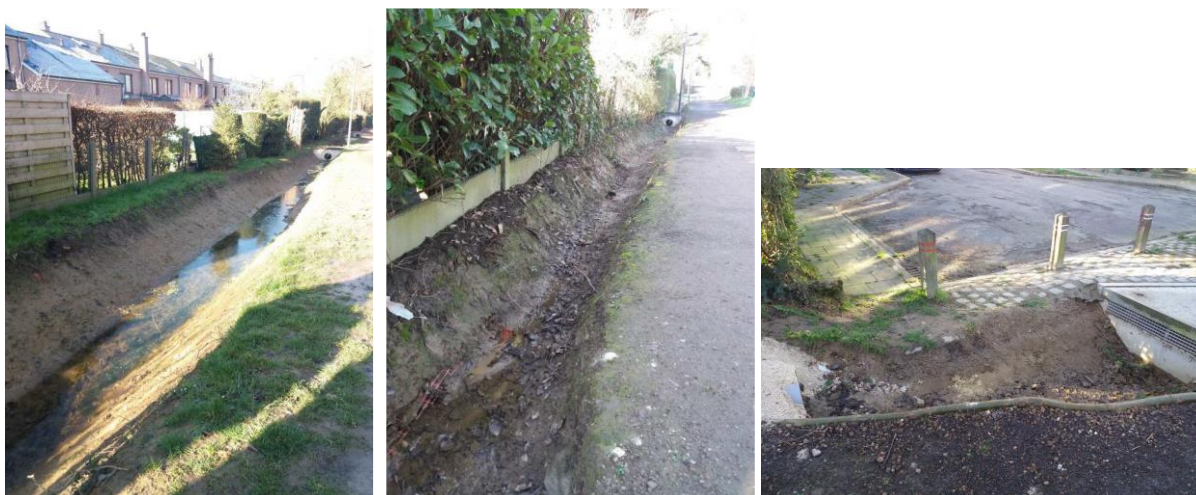
Figure n°81 Illustration des noues réalisées dans le projet d'aménagement de l'Avenue du Cognassier à Berchem-Sainte-Agathe. Source : Vivaqua.
