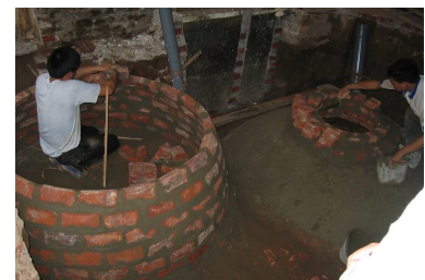
FIGURE 6.18 – Biodigesteur en cours de construction au Vietnam. (Source : Su-SanA.)
