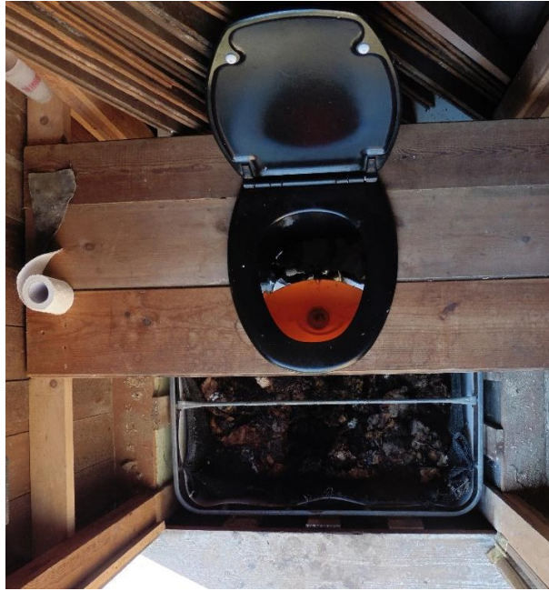
FIGURE A.3 – Vue du siège de toilette avec trappe de maintenance ouverte.
