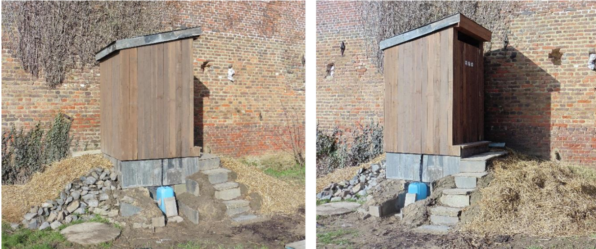
FIGURE A.2 – Vue générale de la toilette.
