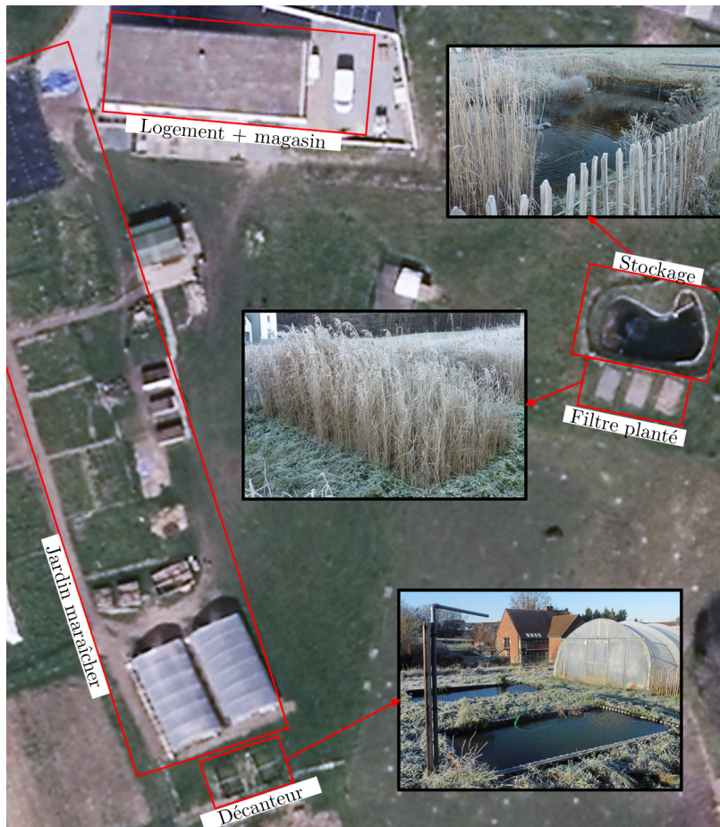
FIGURE 6.19 – Installation pour le traitement, stockage et réutilisation pour l'irrigation des eaux grises au sein d'un projet de maraîchage en Wallonie. (Source personnelle, image aérienne : WalOnMap.)
