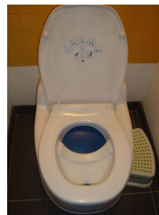
FIGURE 6.30 – Toilette à séparation du fournisseur Separett® installée dans l'habitat participatif Au clair quartier. (Source [10].)
