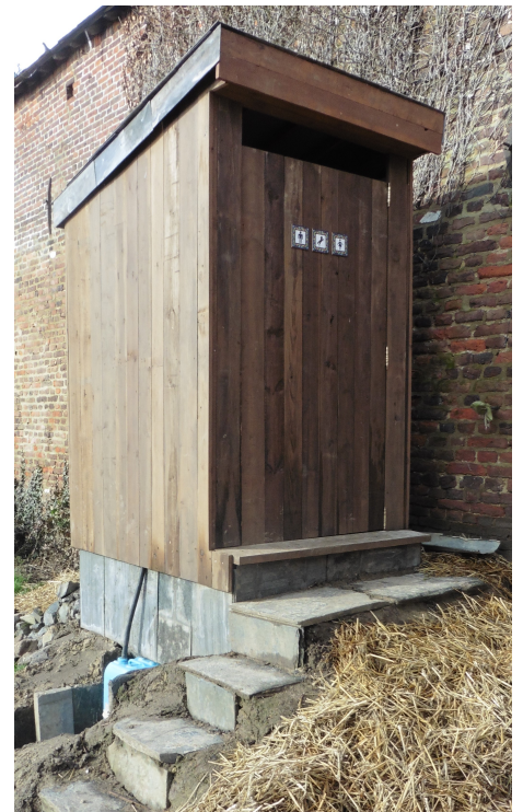
FIGURE 6.25 – Réalisation de la cabine de toilette extérieure.
