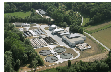
FIGURE 2.1 – Station d'épuration de Basse-Wavre en Brabant Wallon. (Source : inbw.)
