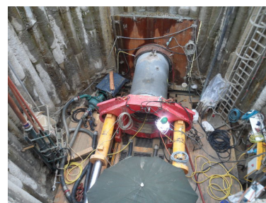
FIGURE 6.1 – Collecteur d'égout en cours d'installation. (Source : inBW .)
