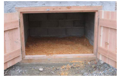
FIGURE 6.11 – Composteur maçonné à la base du bâtiment. (Source : Pierre & Terre.)
