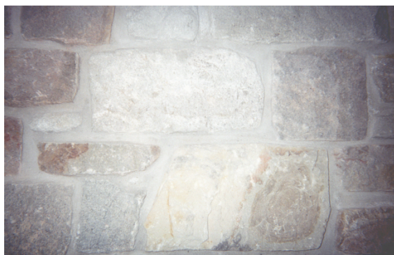
FIGURE 46 – PHOTO PRISE PAR MARIE-FRANCE : MUR
