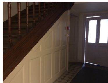
FIGURE 41 – PORTE DU LOCAL DE SERVICE
