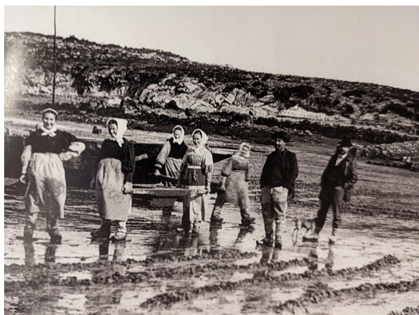
Figure 33. : Chantier Luneau - Le Rouzic, Les Presses à Saint-Philibert. Les premiers ostréiculteurs sont parfois contraints pour s'installer de coloniser une côte rocheuse
