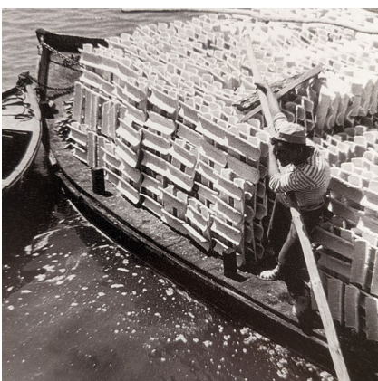
Figure 38. : On charge les tuiles sur le ponton pour transport ©Le Goff P.
