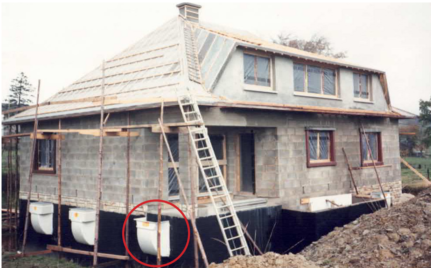
Abb.40: Foto während der Bauperiode, das die erwähnten Lichtschächte zeigt
