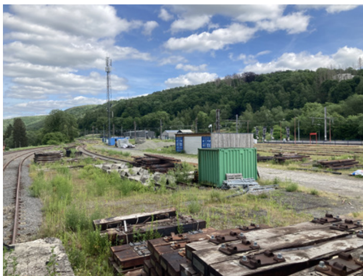
Fig. 21 Ancienne gare de marchandise à Pepinster Photographie personnelle
