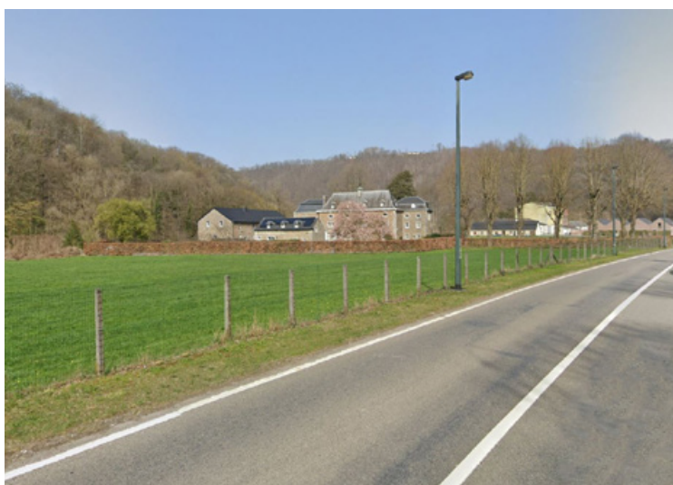
Fig. 18 Richesse du patrimoine bâti de la vallée Source : Google Earth
