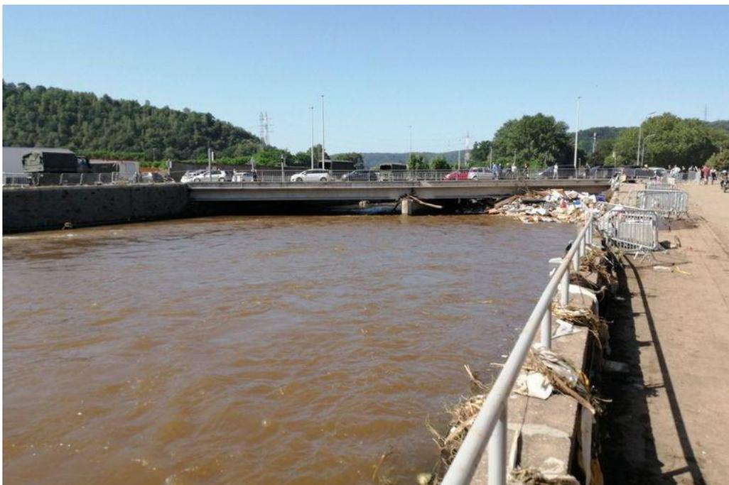
Figure 74 Embâcle généré par le pont du Lhonneux pendant les inondations, 2021, BECHET, [www.dhnet.be](http://www.dhnet.be).
