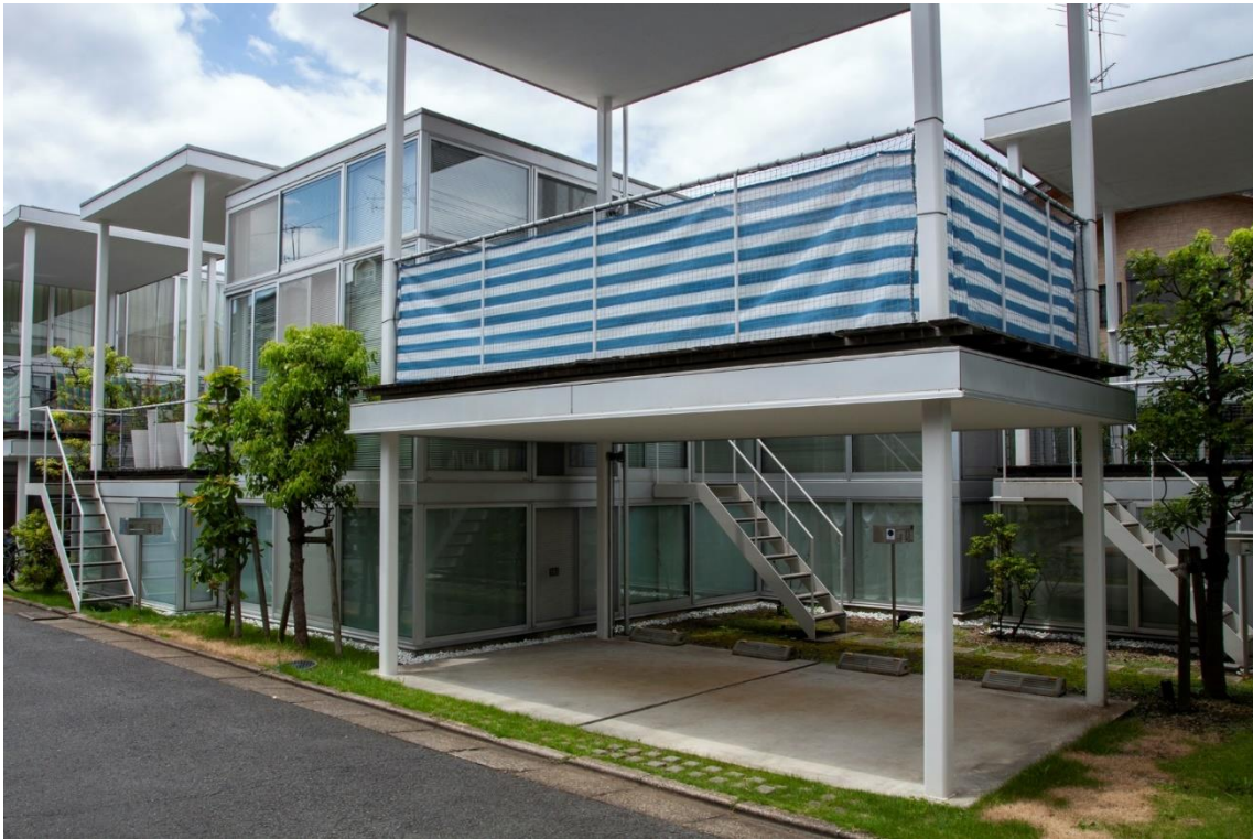
Fig. 59 : Parking et terrasse couverts du logement E du projet Shakujii Apartment
