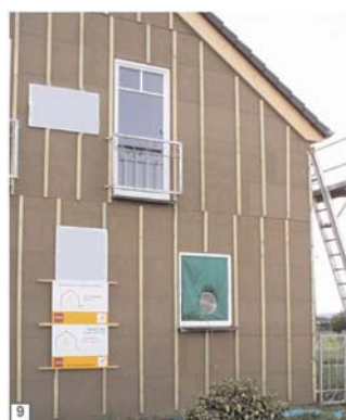
Figure 2.16 : Test Blowerdoor de la maison Kettenis
