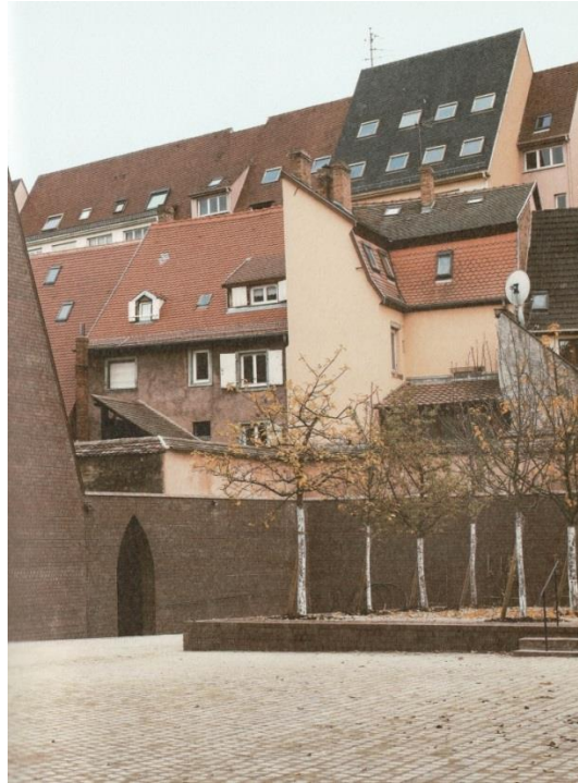
Fig. 11 : Photo des maisons typiques de Colmar depuis la cour de la nouvelle aile Ackerhof du musée Unterlinden.
