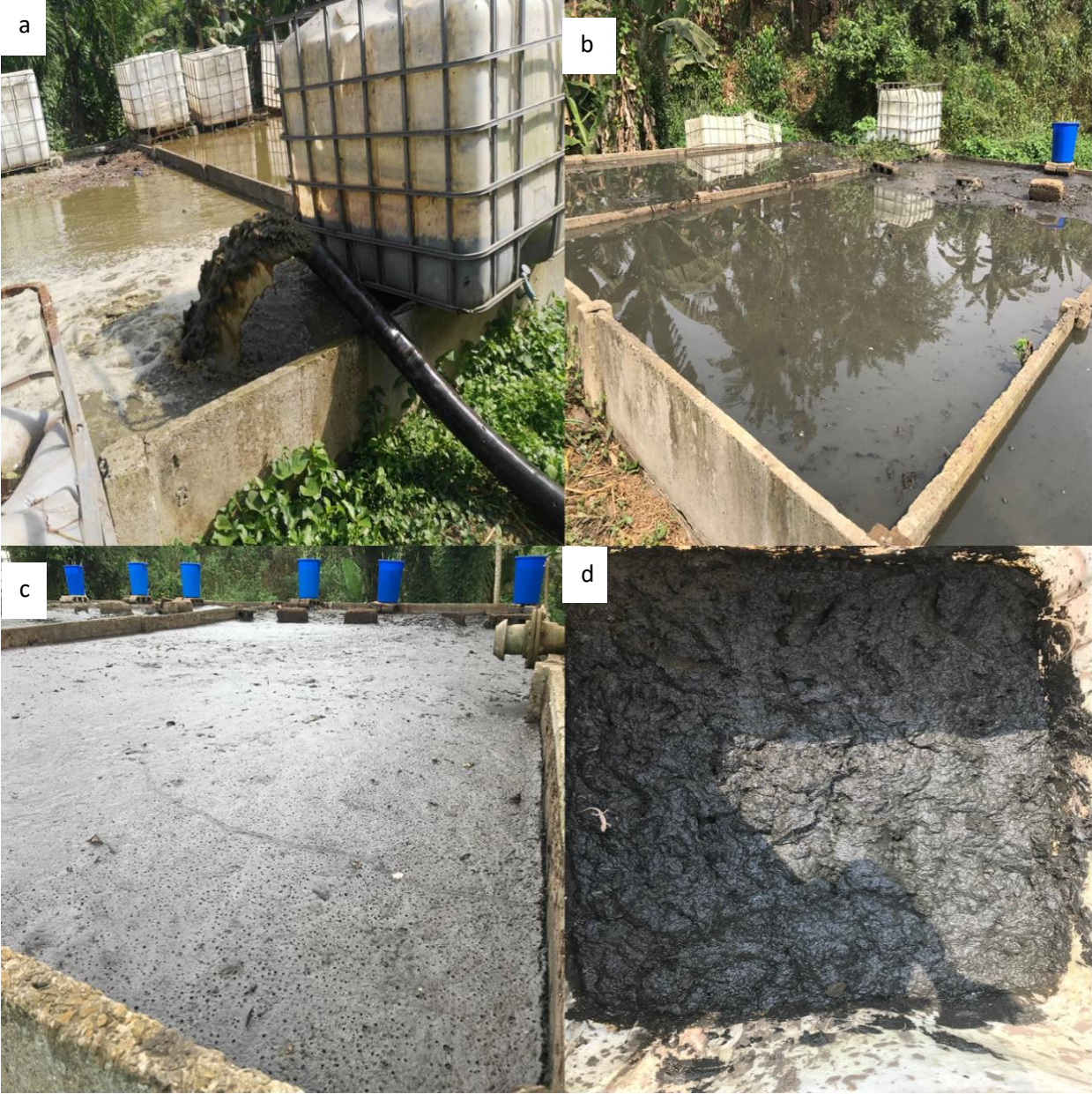
Annexe 1. Quelques images de terrain (a : dépotages des boues sur le filtre ; b :déshydratation c : boues de vidanges déshydratés ; d ; bous stockée après triage.
