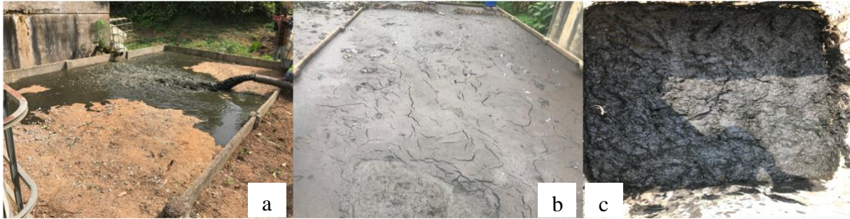
Figure 3. Filtre pour déshydratation des boues (Wafo., 2022) prise personnelle. (a : dépotage ; b : déshydratation ; c : homogénéisation)
