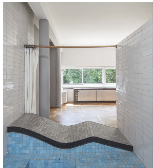
Fig.3.3.: Mobilier intégré dimensionné selon le Modulator dans Villa Savoye © Montse Zamorano | Architecture Photography.
