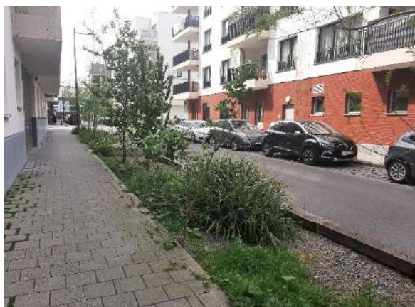
Figure 12 : Photo d'une noue en voirie (document personnel)
