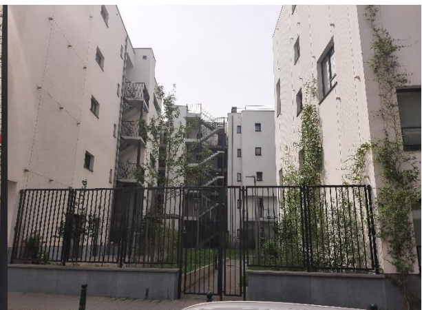
Figure 38 : Intérieur du lot 2 (document personnel)
