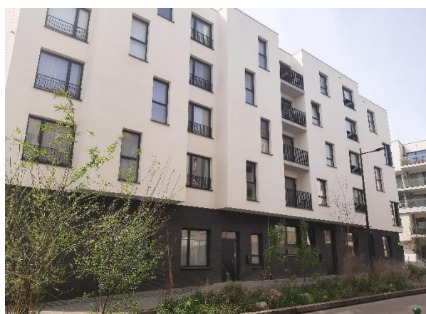
Figure 26 : Noues en voirie (document personnel)
