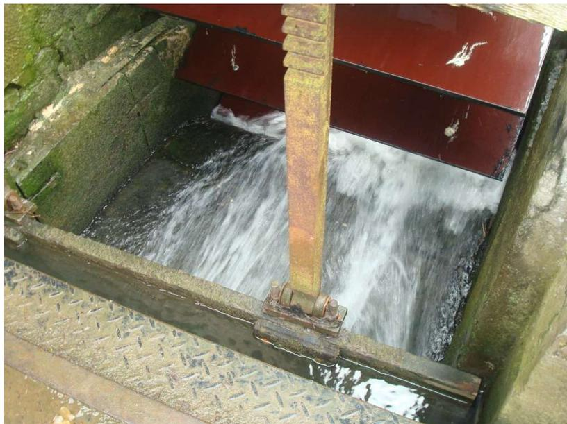
Fig 59 : Photographie de la vanne mollerresse abaissée (s.d.) (<https://mapio.net/pic/p-20325037/>)
