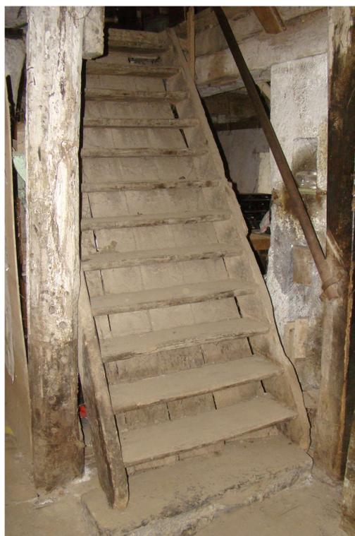
Fig 43 : Photographie personnelle de l'escalier construit entre les poteaux en pierres et en bois
