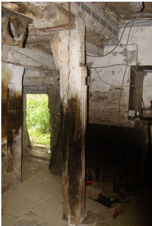
Fig 42 : Photographie personnelle d'un des poteaux supportant la poutre maîtresse
