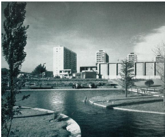
Figure 5 : Photo prise depuis le parc (F. Niffle, Liège).
