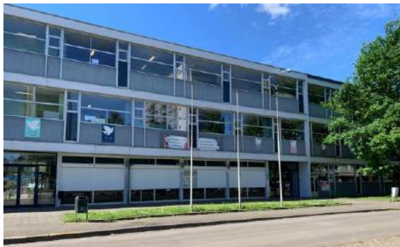
Figure 36 : Façade Nord de l'établissement
