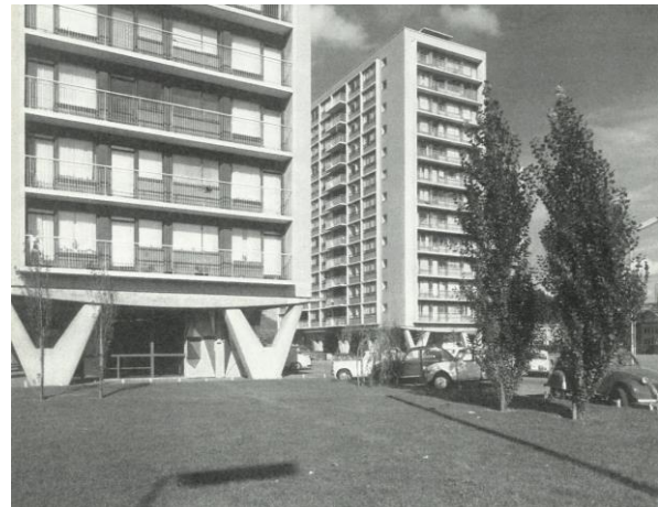
Figure 6 : Aménagement extérieur des immeubles Avenue Truffaut (F. Niffle, Liège).
