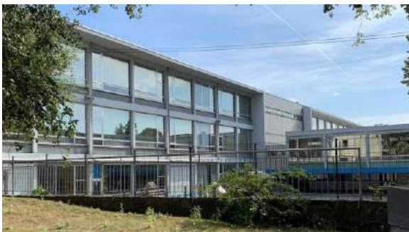
Figure 38 : Façade Sud de l'établissement
