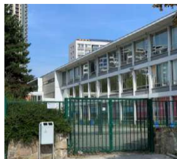
Figure 39 : Façade Sud de l'établissement
