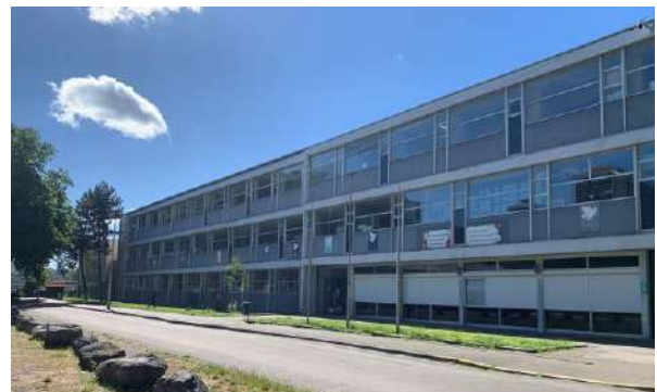
Figure 37 : Façade Nord de l'établissement
