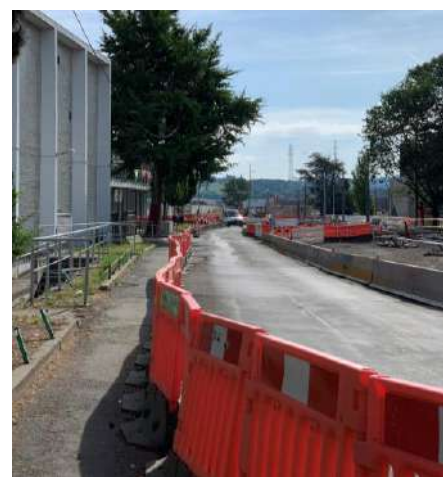
Figure 35 : Travaux du tram devant l'accès à la cour de l'école
