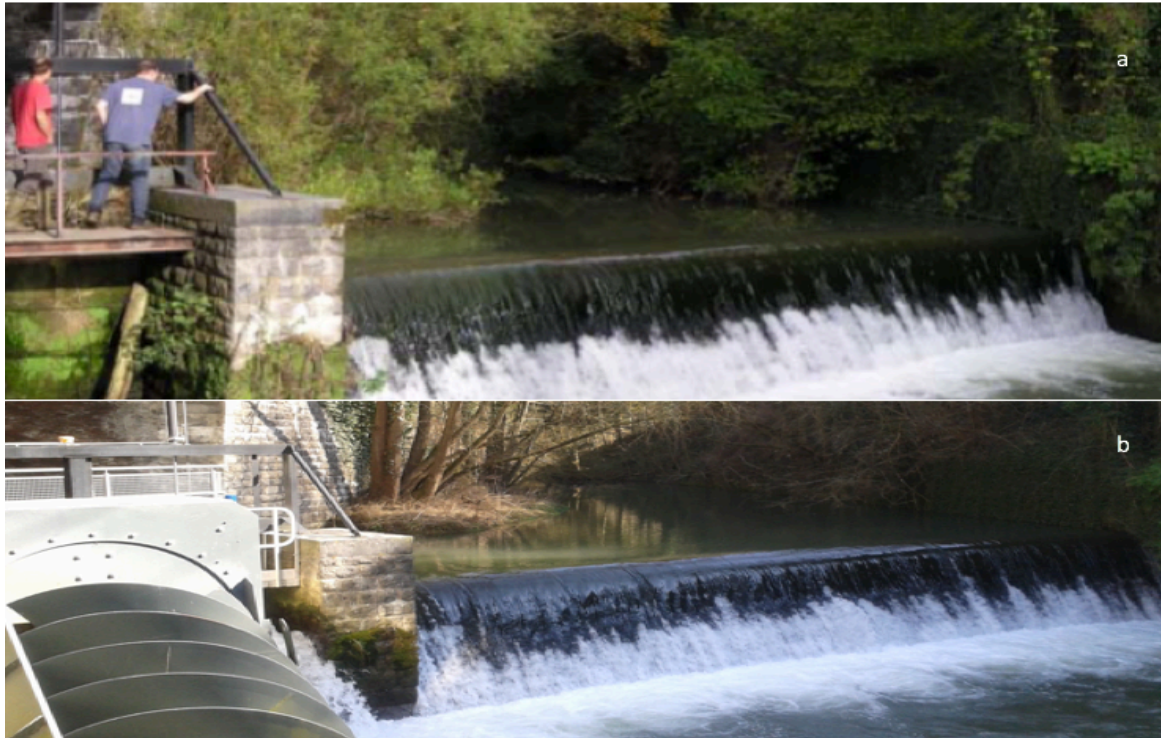
Figure 9 : (a) Vue aval du déversoir du Maka avant travaux. (b) Vue aval après travaux du complexe vis d'Archimède – barrage du Maka
