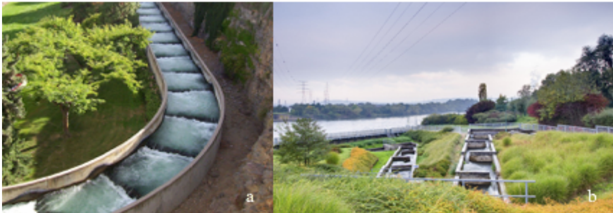
Figure 6 : Echelle à poissons à Washington aux Etats-Unis (a) - Echelle à poissons de Lixhe en Belgique (b).
