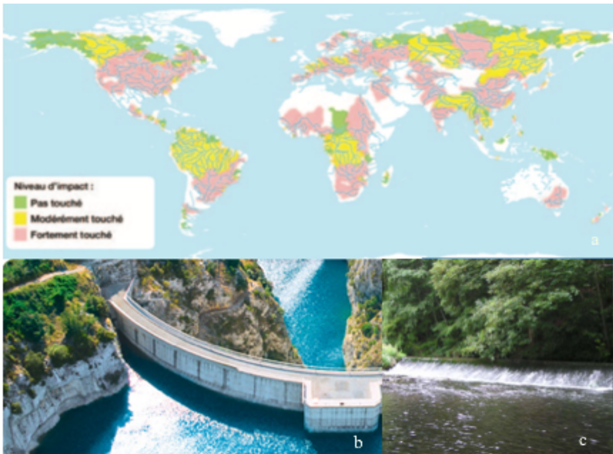
Figure 5 : Classification des impacts basée sur la fragmentation des chenaux fluviaux et la régulation des débits des cours par les barrages dans 292 des plus grands réseaux hydrographiques du monde (Source : Nilsson et al., 2005) (a) – Barrage de Sainte Croix du Verdon en France (b) – Seuil sur la rivière du Bocq en Belgique (c).
