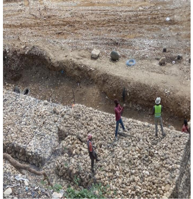
B-Gabionnage sur la berge de la rivière
