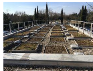
Figure 10 : Photos du design expérimental du toit vert. La photo correspond à la partie supérieure de la Figure 2.
