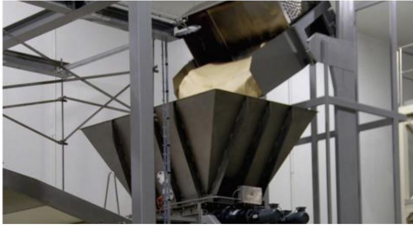
Figure 94 : Déchargement de la pâte de la cuve de mélange vers la cuve d'alimentation de l'extrudeuse (Davidson, 2018).
