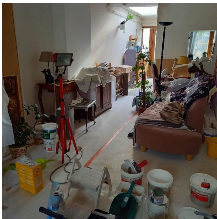
Figure 49 – La salle à manger occupée, entre les travaux et le retour à la normale (Famille Dennis, Angleur, 2022).
