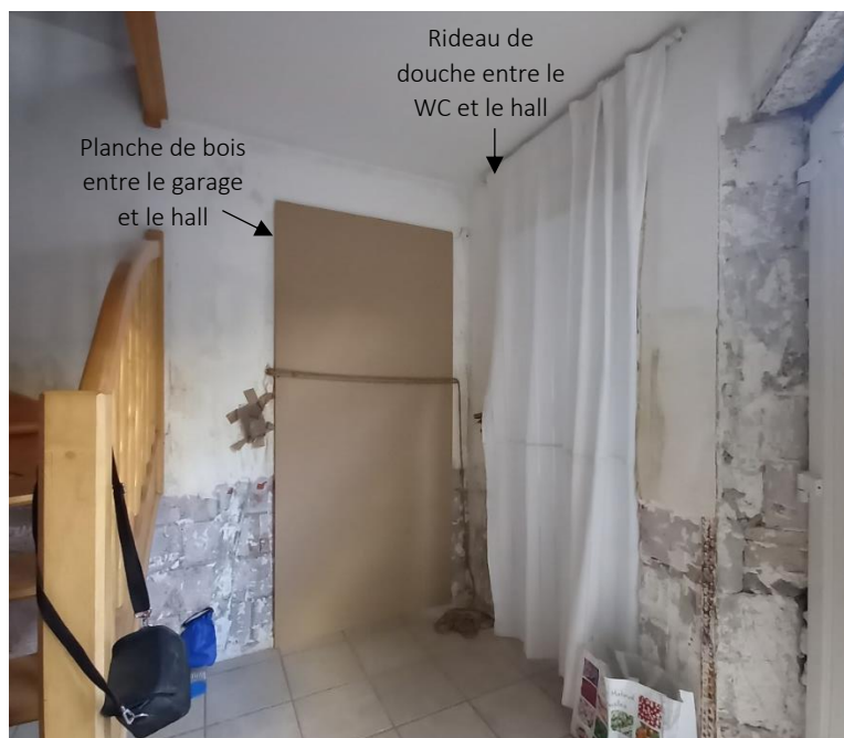
Figure 38 – Les deux portes intérieures remplacées par des solutions temporaires (Famille Perrault, Chaudfontaine, 2022).
