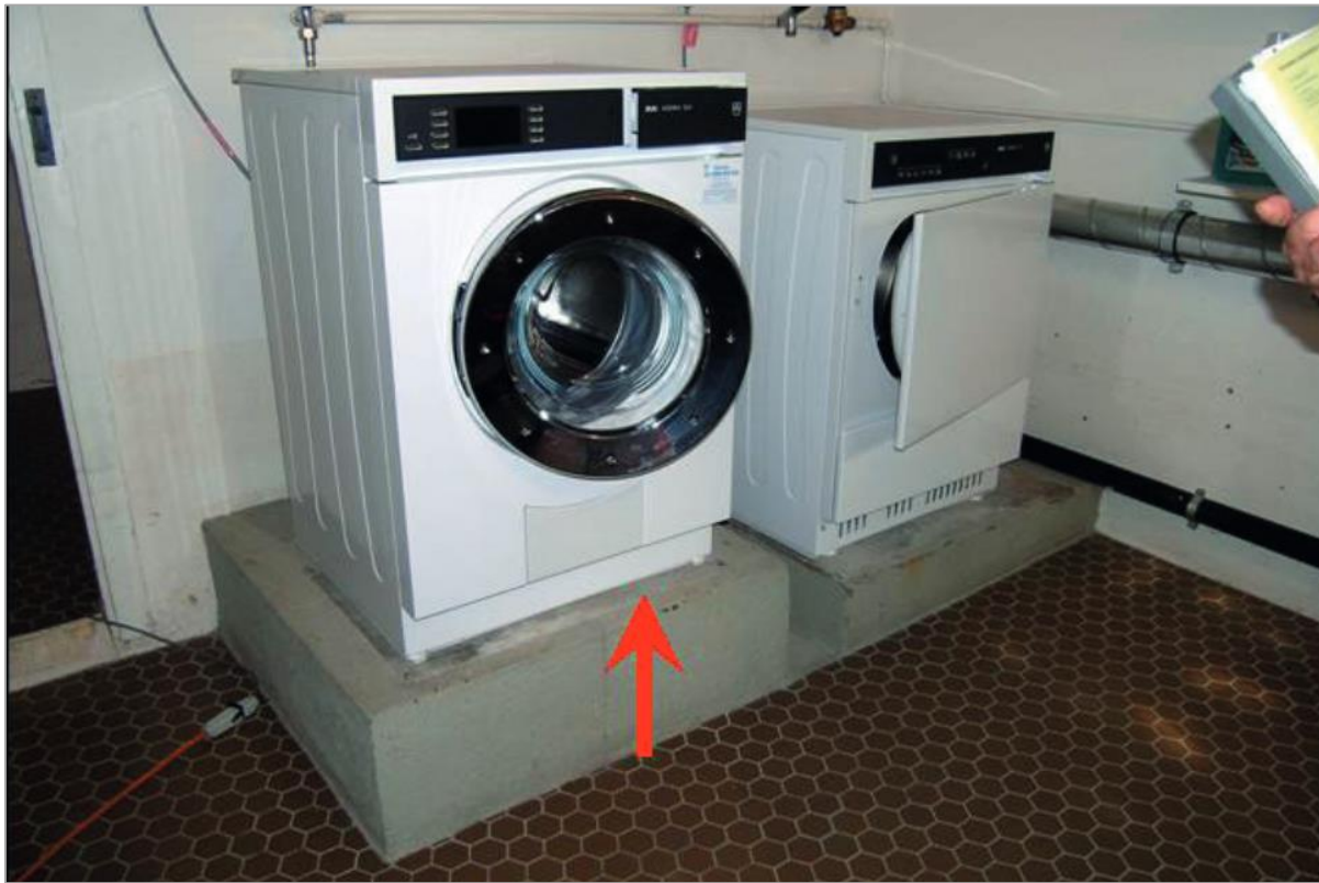
Figure 40 : Mesure de réduction de la vulnérabilité par la technique du rehaussement – (Leroy et al. 2013, p.132)
