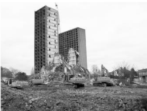
Démolition des blocs 9 à 13 de Droixhe, n.d., Castagni
