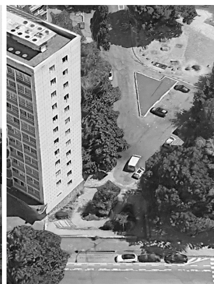
Figure 39 L'alternative de la rampe accompagnant l'escalier, bloc 1, 2020, Google Earth
