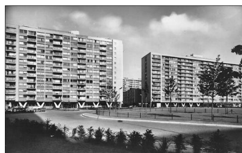
Vue sur le bloc 6 et 7
