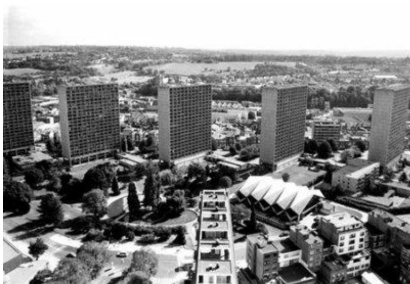
Figure 60 Les blocs 9 à 13 vus depuis la Tour Atlas
