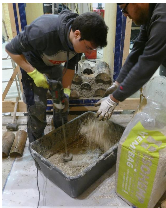
Illustration 52 : Préparation du béton de chanvre
