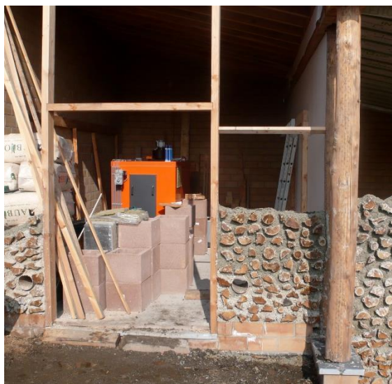
Photo 3 : Mise en œuvre bois-cordé et encadrements de baies
