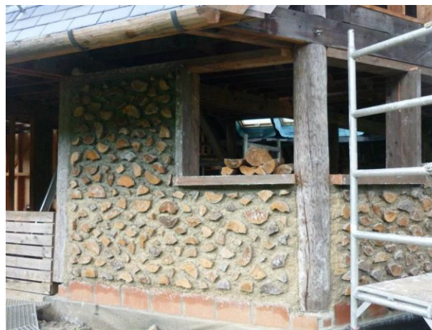
Illustration 34 : Raccord d'angle et encadrement de baies
