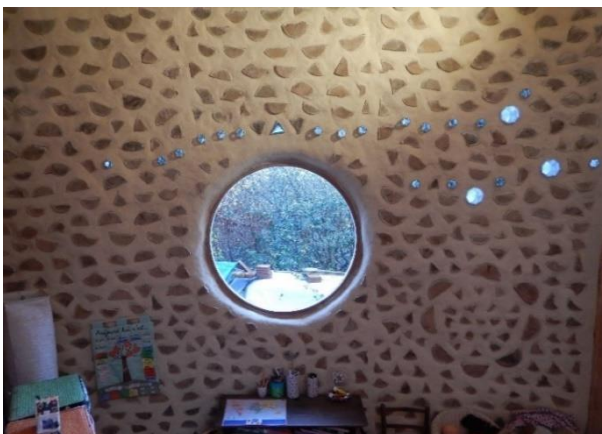
Mur en bois cordé côté intérieur
