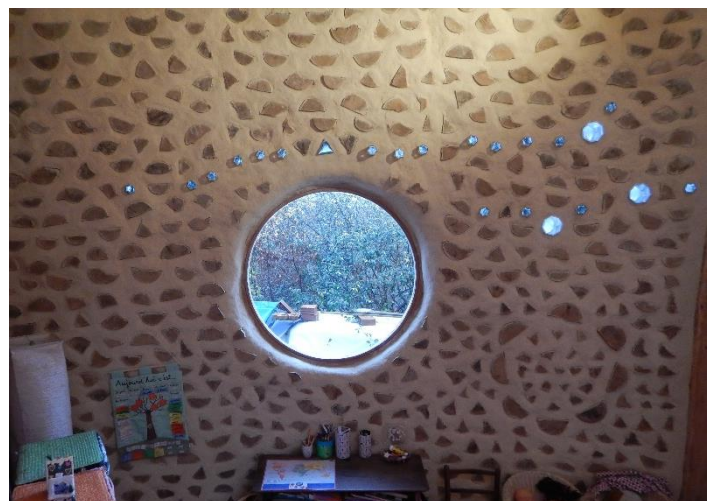
Illustration 44 : Mur en bois cordé côté intérieur
