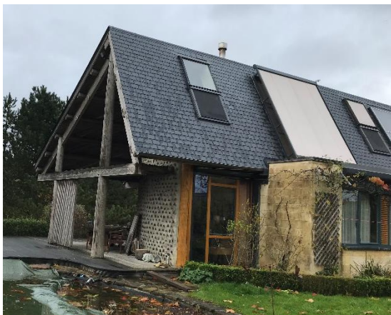
Façade principale en bois cordé et débordant de toiture
