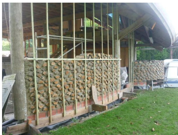
Illustration 33 : Mise en œuvre bois cordé
