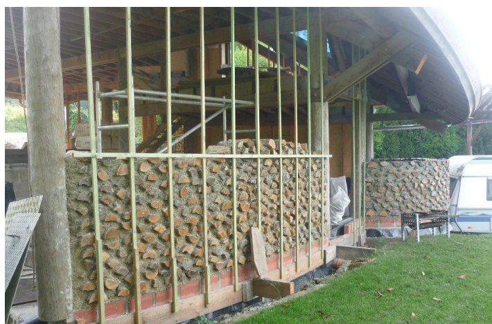
Photo 3 : Mise en œuvre du bois-cordé
