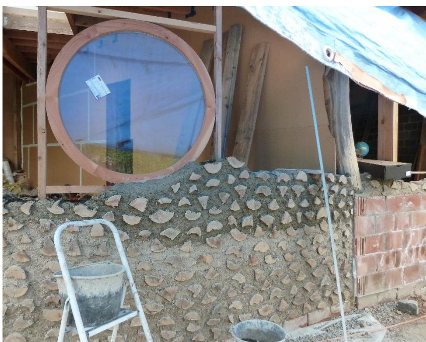
Illustration 40 : Mise en œuvre bois cordé, encadrement de baie et châssis
