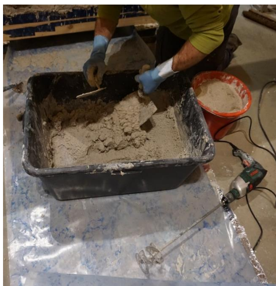
Illustration 53 : Préparation de l'enduit à la chaux
