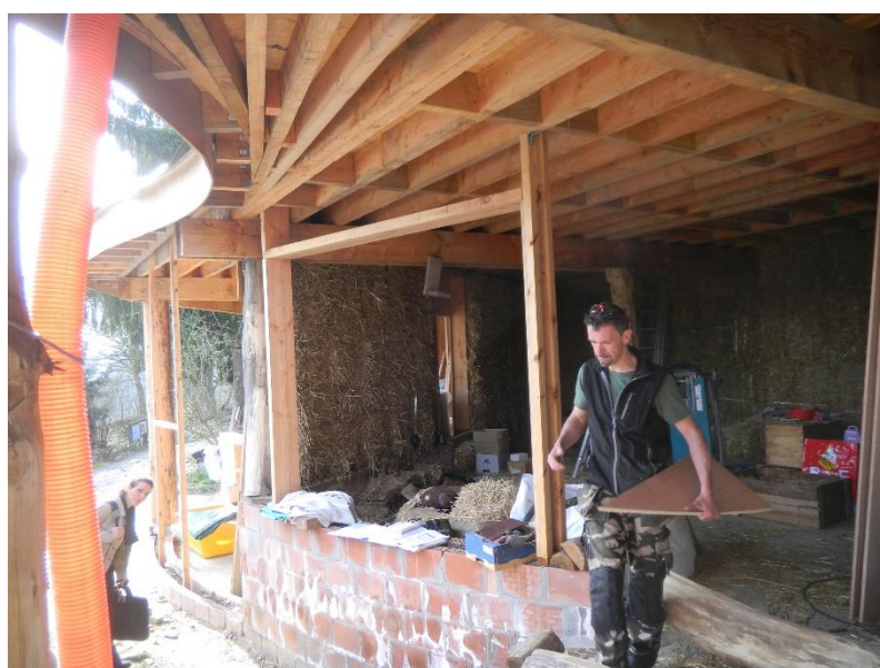
Photo 2 : Structure couverte et encadrements de baies
