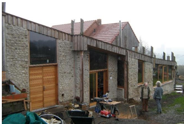
Illustration 28 : Façade avant la mise en place du bardage
