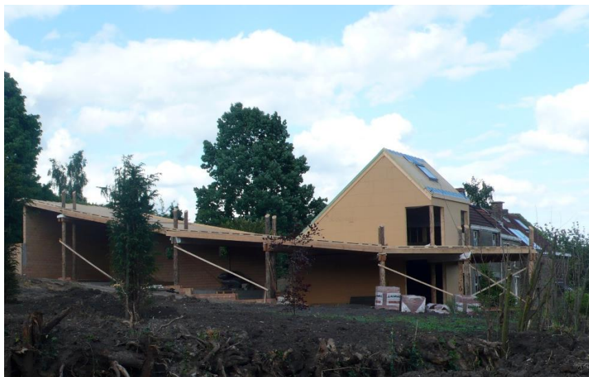
Photo 1 : Structure principale avec couverture
