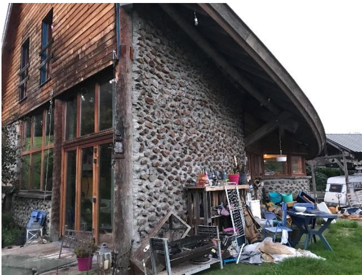
Illustration 36 : Façade principale en bois cordé et débordant de toiture
