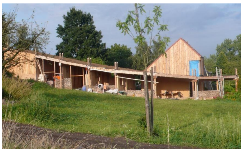
Illustration 26 : Mise en œuvre bois cordé, vue d'ensemble
