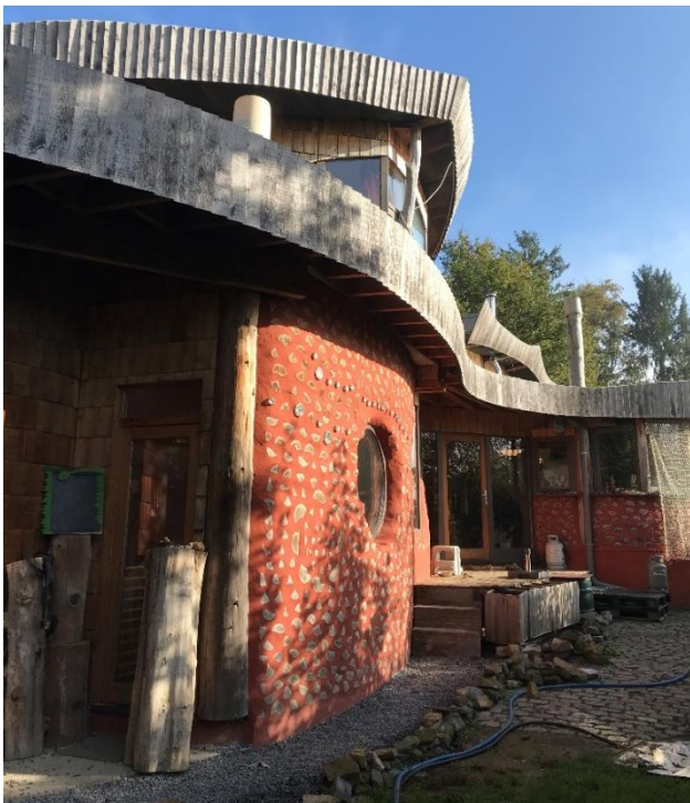
Illustration 43 : Façade principale en bois cordé et débordant de toiture
