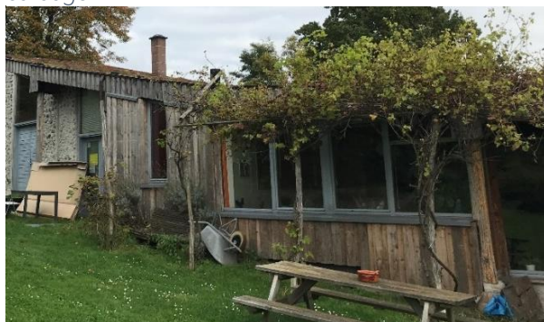
Illustration 29 : Façade avec bardage
