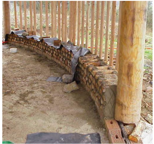
Illustration 15 : Mise en œuvre et pied de mur
