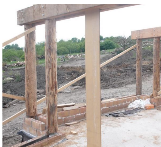
Illustration 24 : Soubassement et structure principale
