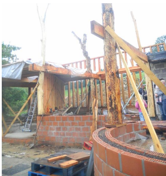
Photo 1 : Soubassement et structure principale
