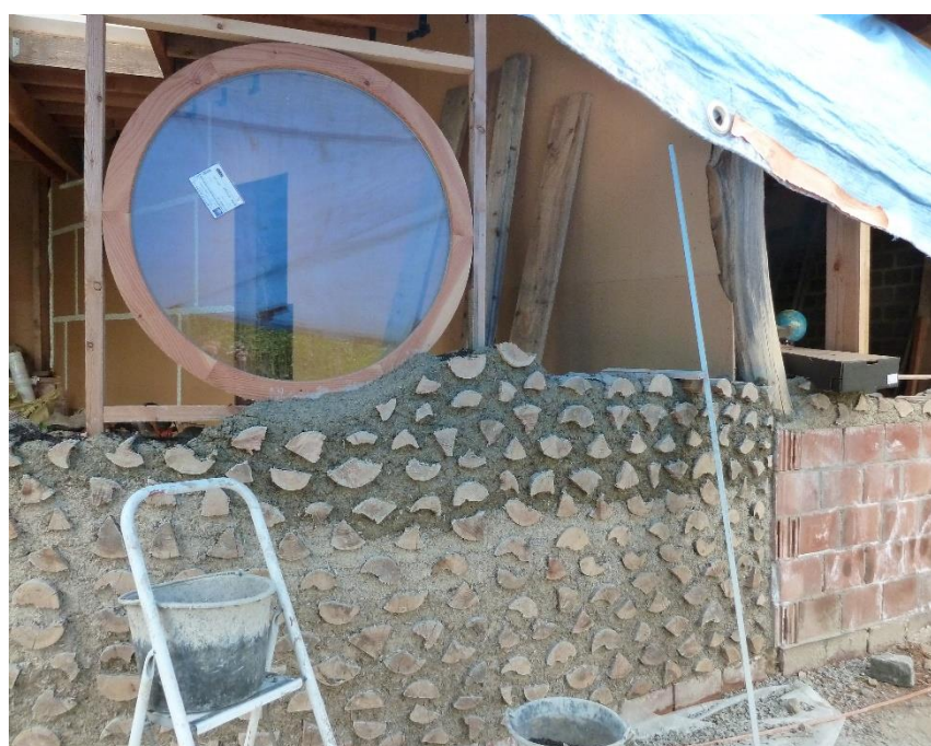
Photo 8 : Mise en œuvre bois-cordé, encadrements et châssis
