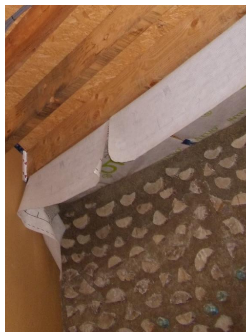
Illustration 41 : Raccord mur-toiture
