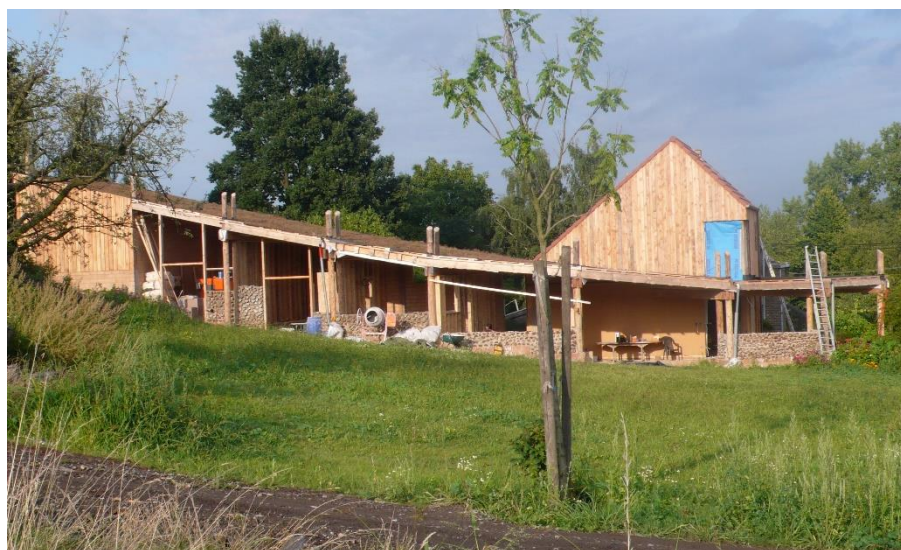
Photo 4 : Mise en œuvre bois-cordé, vue générale
