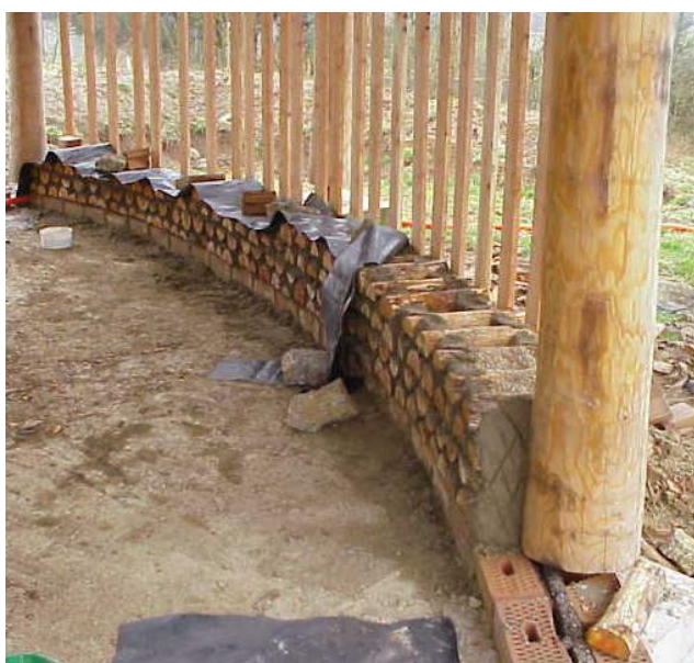
Photo 3 : Mise en œuvre bois cordé et pied de mur
