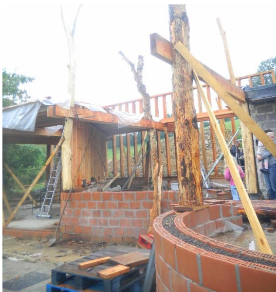
Illustration 38 : Soubassement et structure principale
