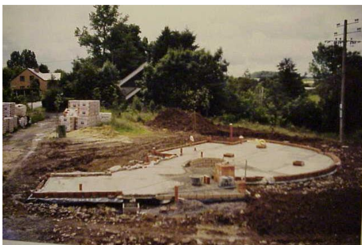
Photo 1 : Fondations et soubassement
