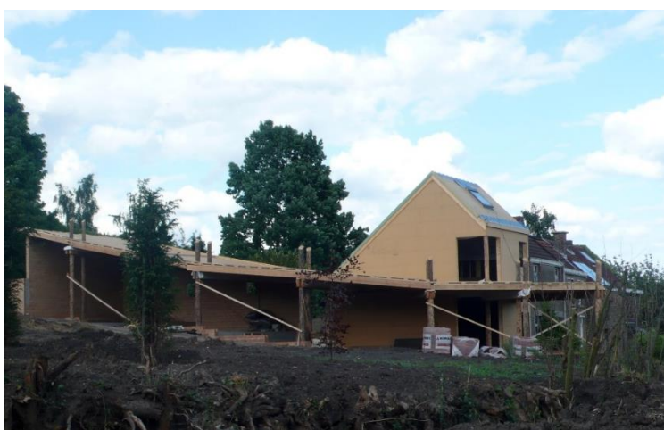
Illustration 23 : Structure principale avec couverture
