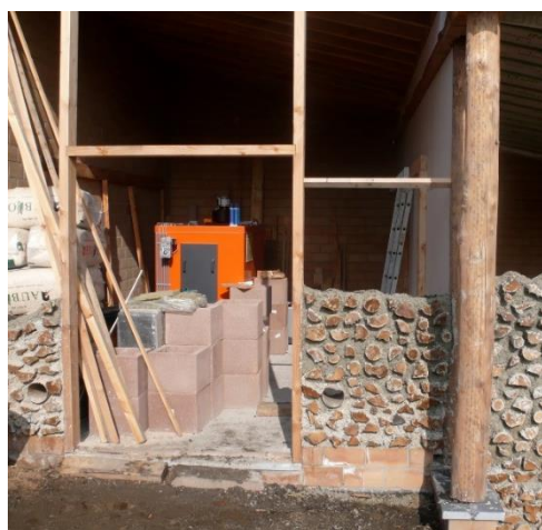
Illustration 25 : Mise en œuvre bois cordé et encadrement de baies
