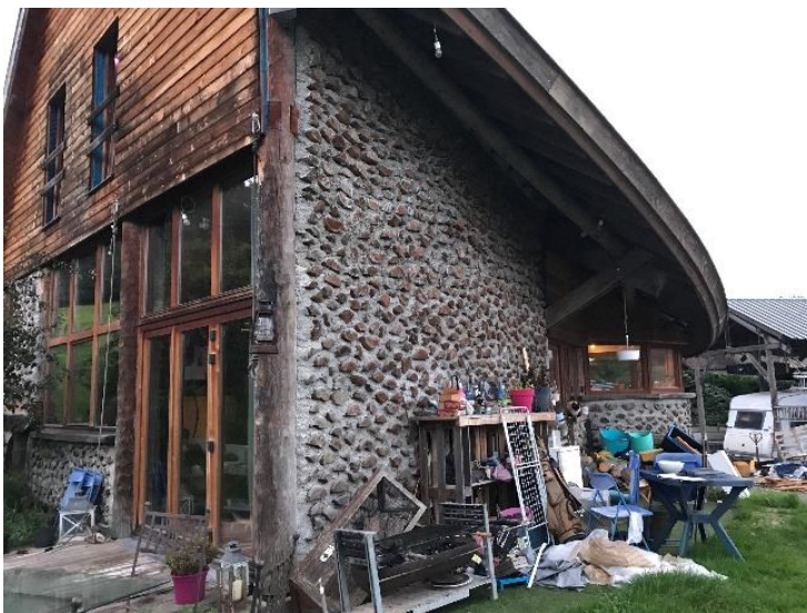
Façade principale en bois cordé
