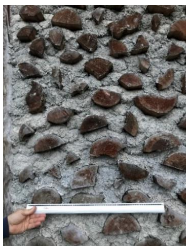
Illustration 12 : Élévation en bois cordé
