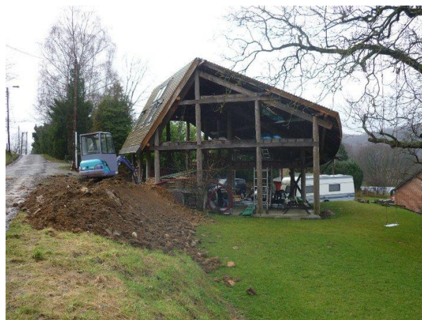
Illustration 32 : Structure principale avec couverture
