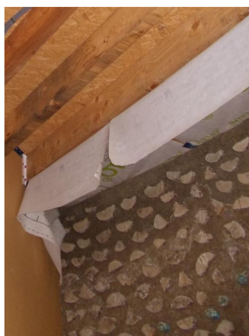
Photo 9 : Raccord en toiture
