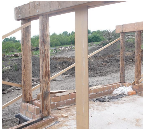
Photo 2 : Soubassement et structure principale
