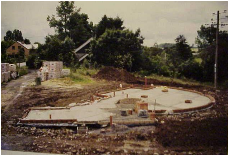
Illustration 14 : Fondations et soubassement
