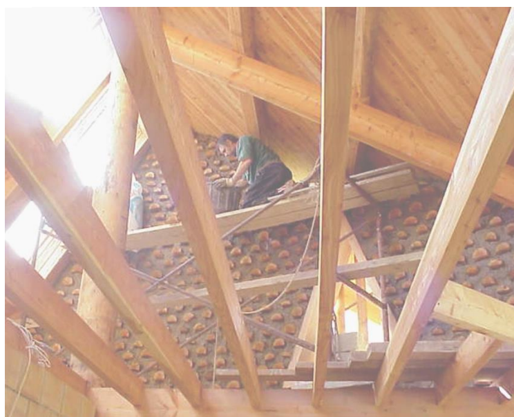
Photo 4 : Mise en œuvre bois cordé, raccord en toiture et encadrements de baies
