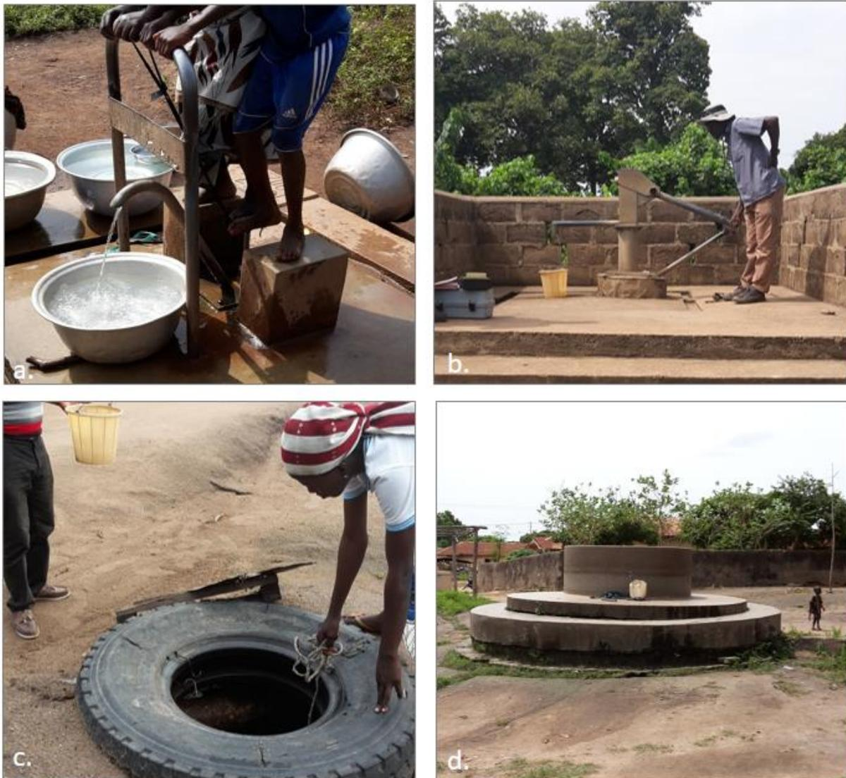
Figure 6 : Types d'ouvrage, a. forage à motricité humaine type Vergnet, b. forage à motricité humaine type India, c. puits à petit diamètre, d. puits à grand diamètre. a. et b. capte la nappe profonde ; c. et d. capte la nappe d'altérites.
