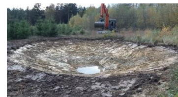
Fig. 76 : Creusement d'une mare dans la forêt d'Engis pour le Life Pays Mosan afin de favoriser l'accueil des chauves-souris. [Source : Life Pays Mosan, 2021]
