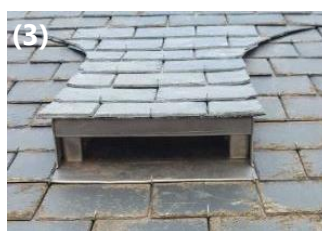
Fig. 84-85-86 : (1) Nichoirs à chauves-souris installés dans les combles d'une maison forestière d'Outrelouxhe (2) Chiroptière dans le toit d'un cabanon à Amay (3) Chiroptière installée dans la toiture du Château de Xhos [Source : Life Pays Mosan, 2021]
