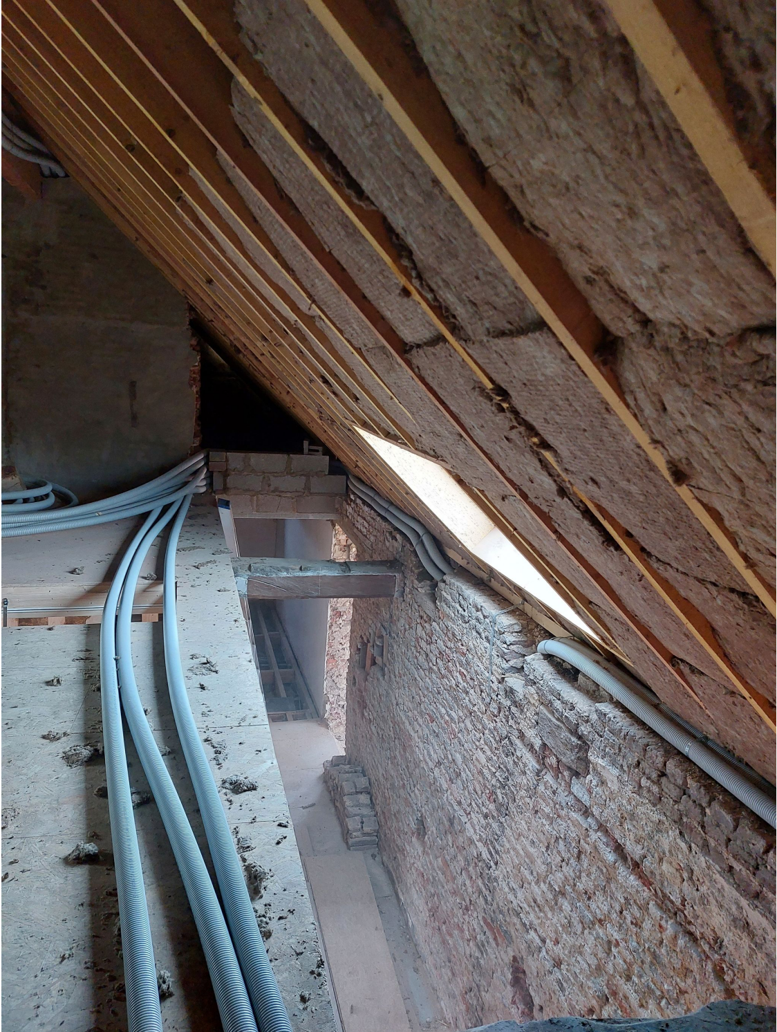
Figure 24 - Pose de l'isolant en toiture par Pierre – Photo réalisée par l'habitant
