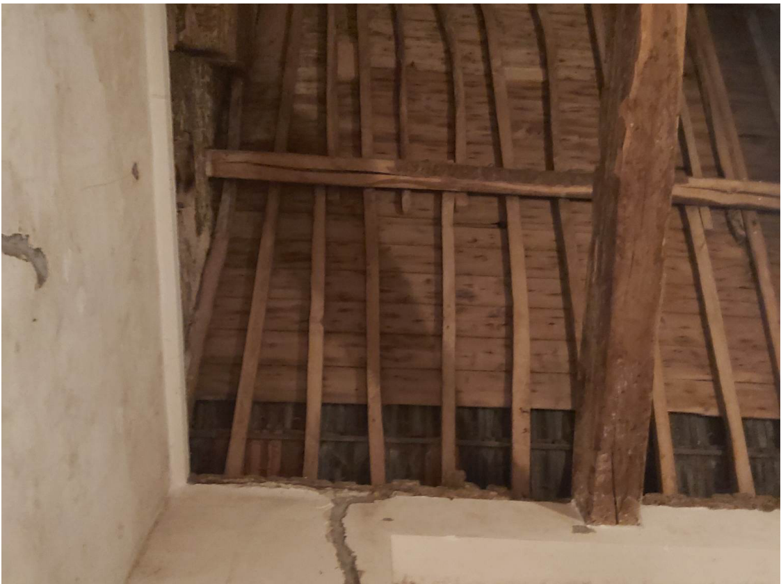
Figure 23 - Toiture existante de Pierre – Photo réalisée par l'habitant
