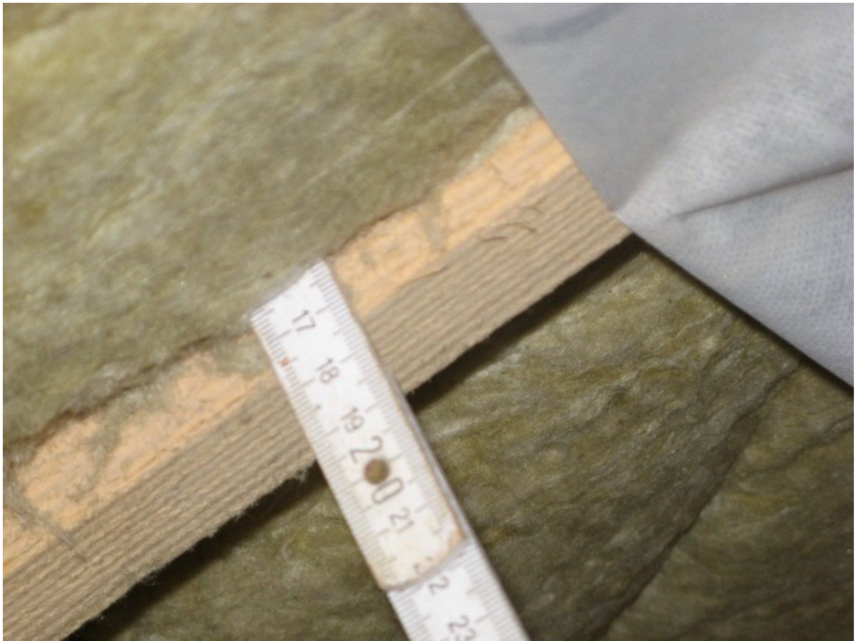
Figure 18 - Épaisseur de l'isolation présent en toiture - Réalisée par l'habitant
