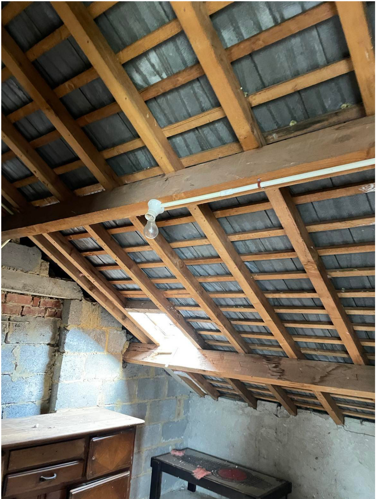
Figure 33 - Toiture existante de Mathilde – Photo réalisée par l'habitante
