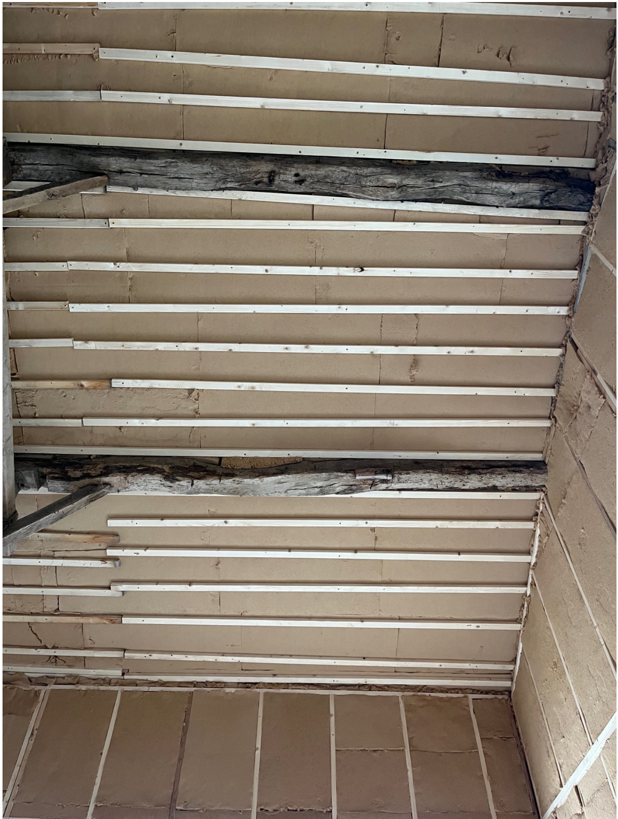
Figure 13 - Mise en œuvre de l'isolation de la toiture - Photo réalisée par mes soins
