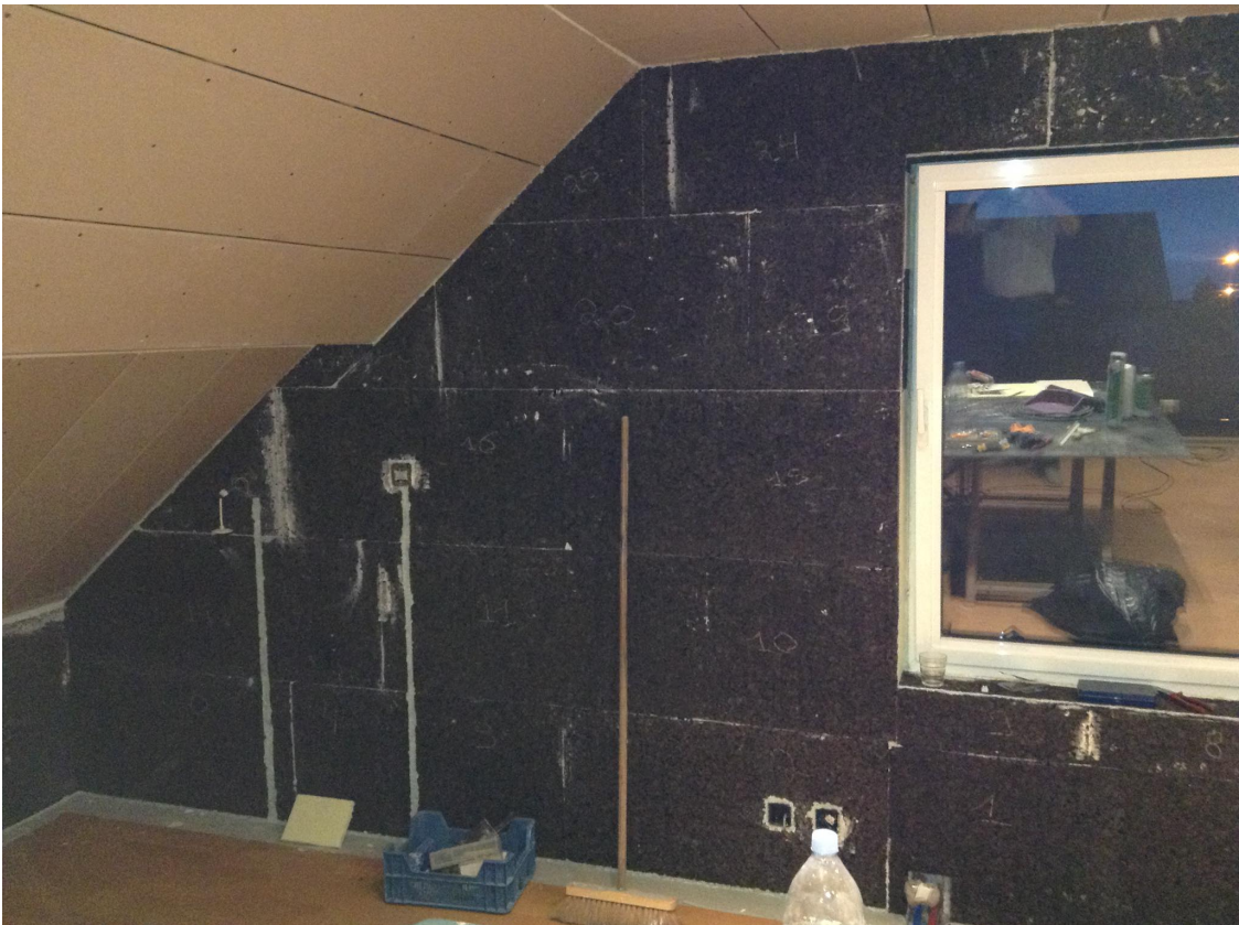
Figure 42 - Pose de panneaux de liège sur les murs – Photo réalisée par l'habitant
