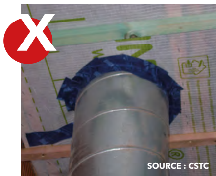
Pose tangentielle des bandes adhésives (à déconseiller)
