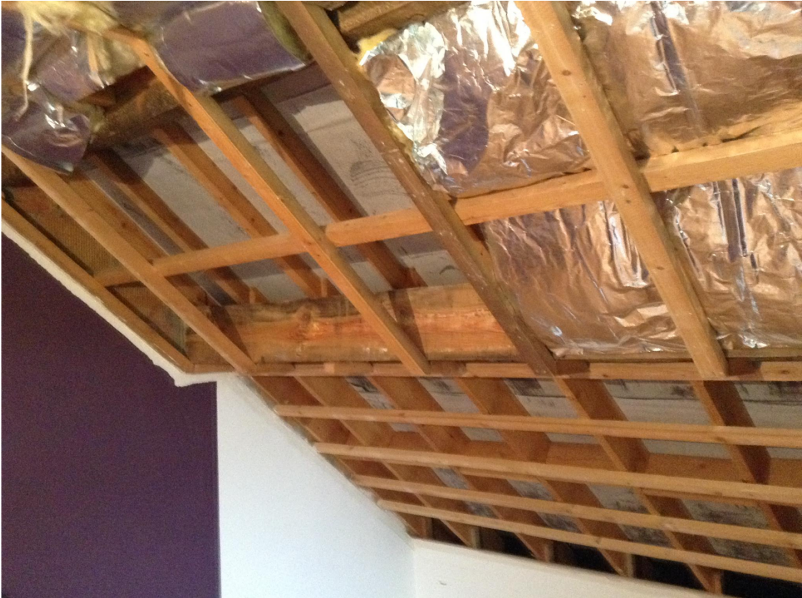
Figure 39 - Toiture avant les travaux de Marc – Photo réalisée par l'habitant
