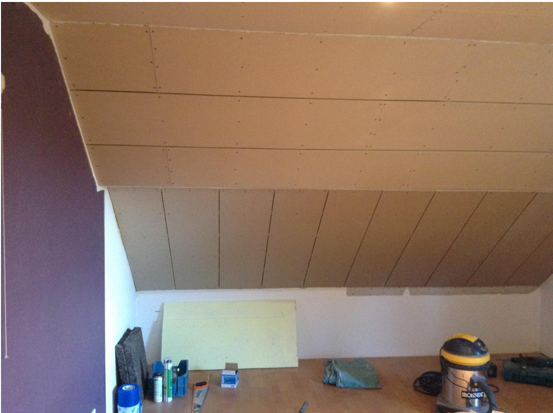
Figure 40 - Toiture de Marc après ses travaux – Photo réalisée par l'habitant
