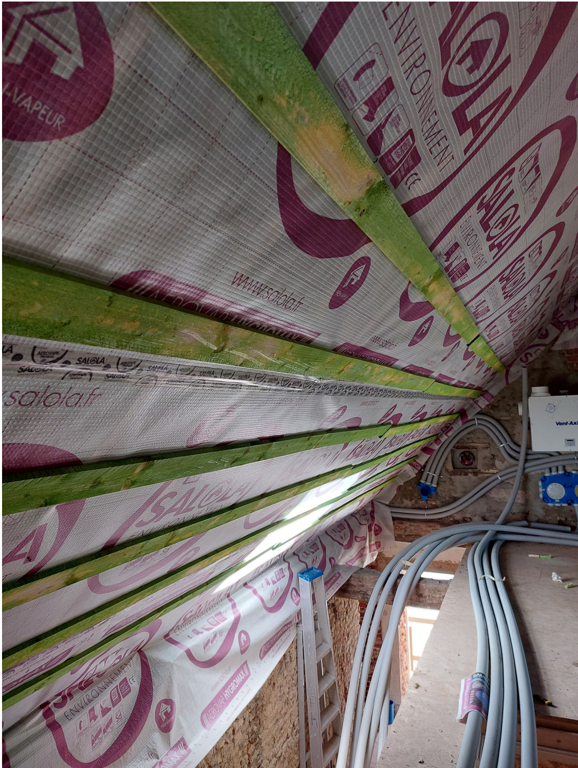
Figure 25 - Pose du pare-vapeur et du lattage par Pierre – Photo réalisée par l'habitant
