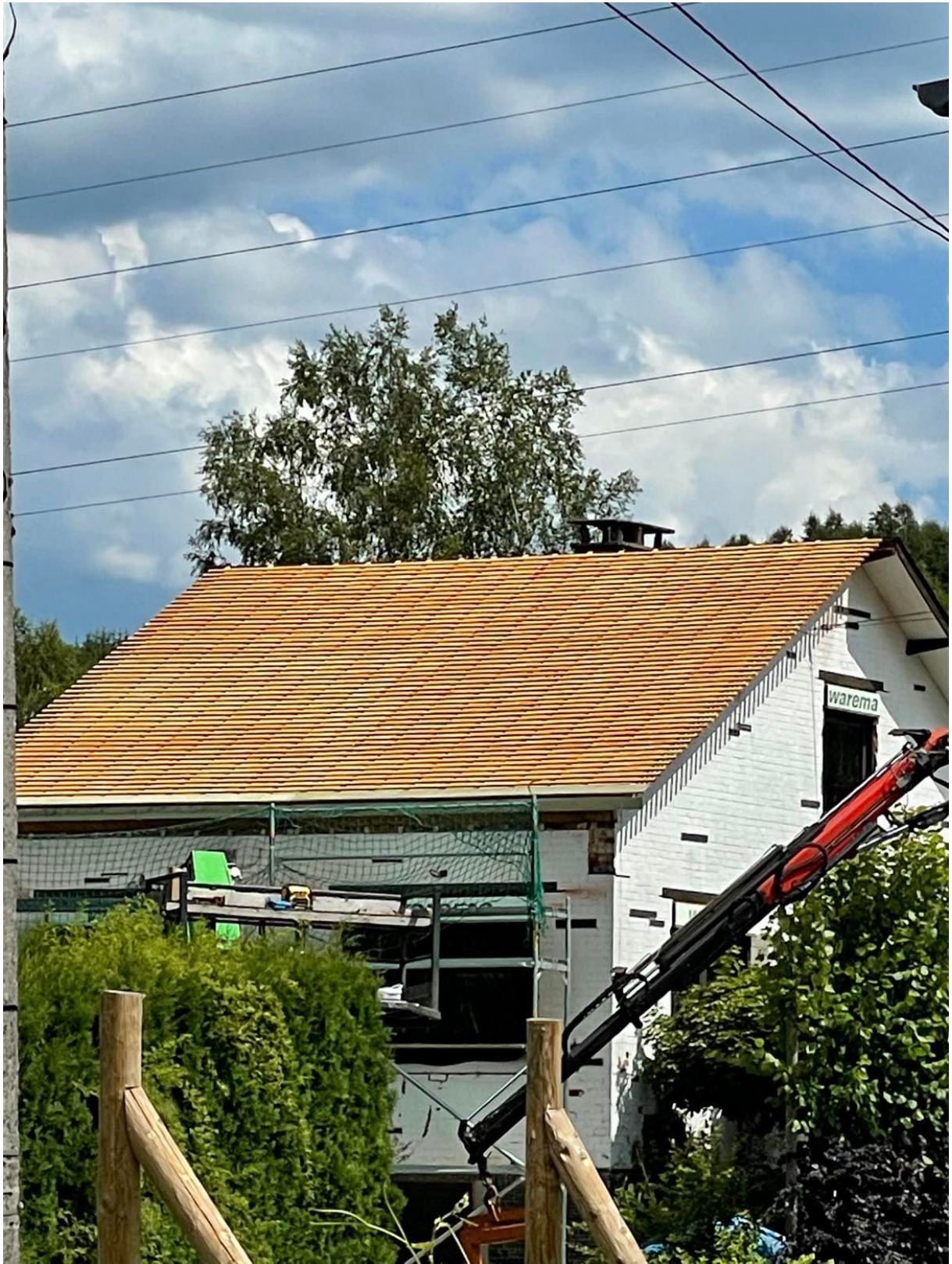
Figure 34 - Nouveau voligeage de la toiture de Mathilde – Photo réalisée par l'habitante
