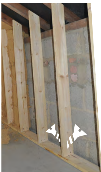
Vissage en oblique de part et d'autre du montant
