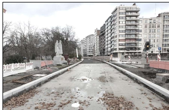
Illustration 117 : Travaux du projet du Tram : Avenue Rogier vers la place Saint-Lambert
