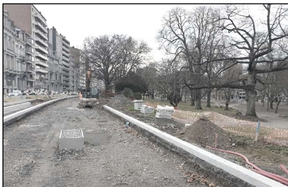
Illustration 116 : Travaux du projet du Tram : Avenue Rogier vers les Guillemins
