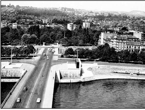
Illustration 68 : vue du pont du Commerce vers les Terrasses - 1950
