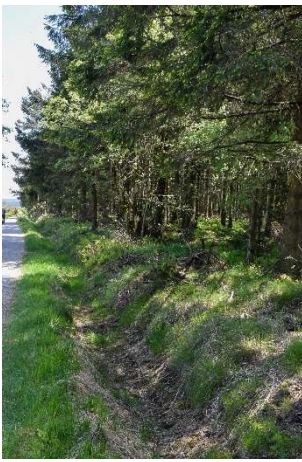
Figure 17 : Exemple de drain (photo personnelle)
