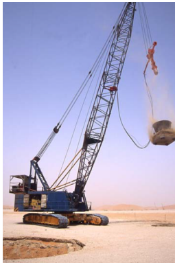
(a) Compactage dynamique
