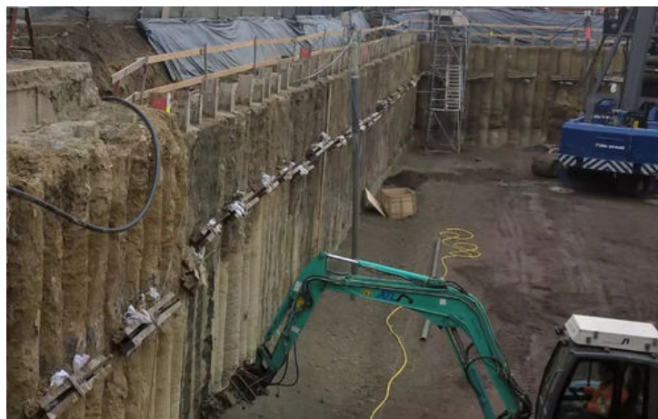
FIGURE 2.19 – Mur de soutènement [ARCHIEXPO 2023]
