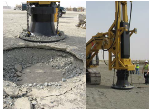
(b) Compactage en surface
