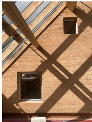
Figure 40 : Mur en pisé (hé! architectuur, 2022)
