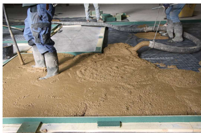
Figure 26 : Coulée d'une chape en terre crue © BC materials
