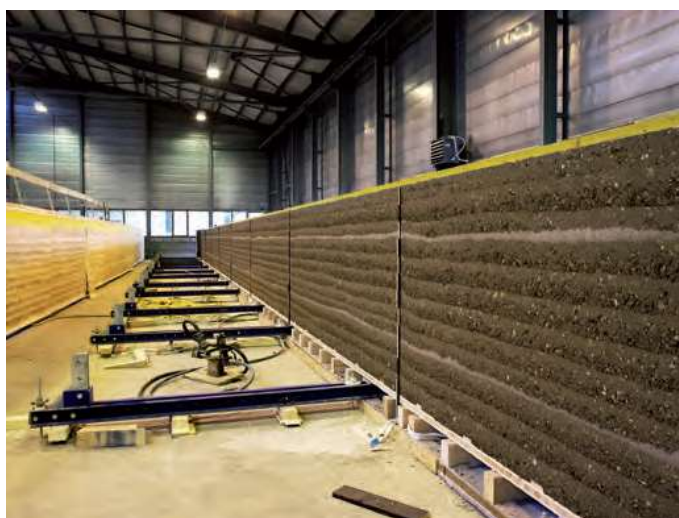
Figure 47 : Retouche des joints entre les éléments préfabriqués (Gauzin-Müller, 2018)
