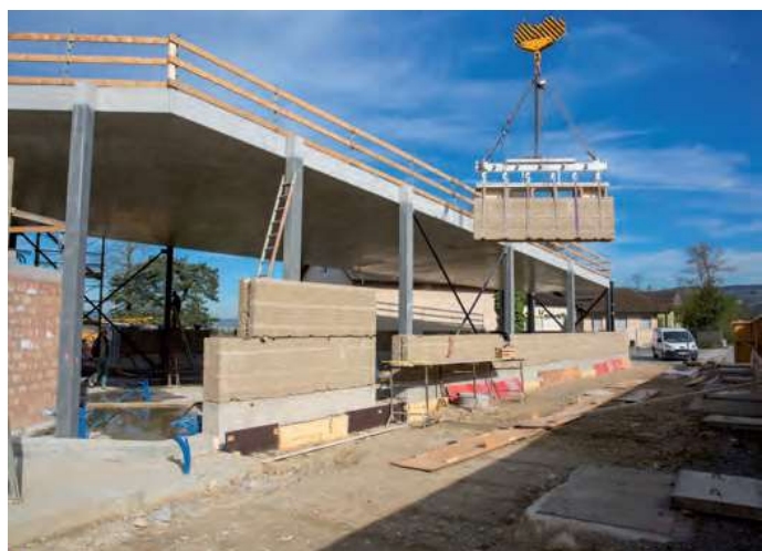
Figure 43 : Pose des éléments préfabriqués (Gauzin-Müller, 2018)
