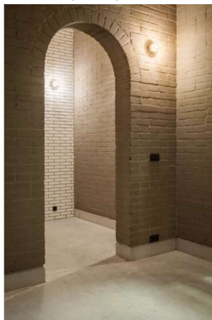
Figure 24 : Murs construits en BTC © BC materials
