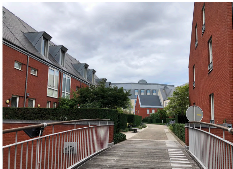
Fig.59. Vue de l'ensemble résidentielle depuis la passerelle suspendue
