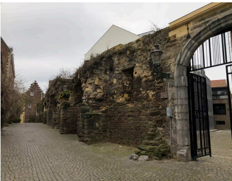
Fig.30. Côté intérieur de l'enceinte
