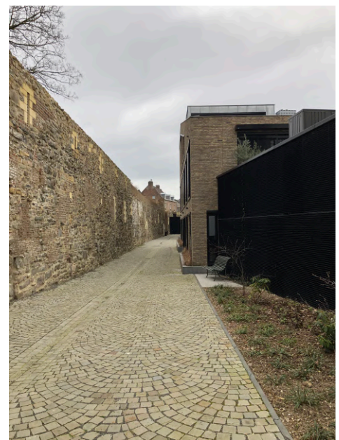
Fig.31. Côté extérieur de l'enceinte, mais intérieur à Looiershof
