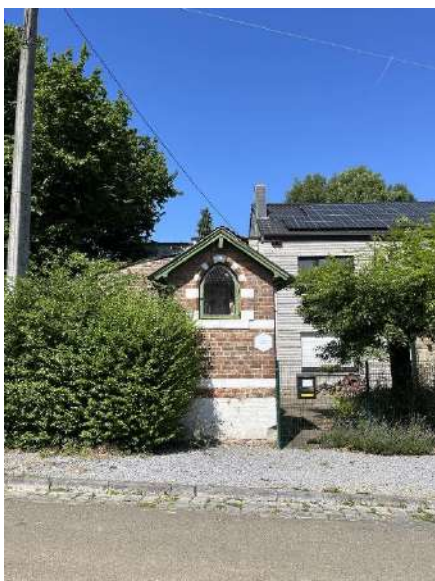
Figure 53: façade à rue de la potale. Louise Schröder, 7 juillet 2023.
