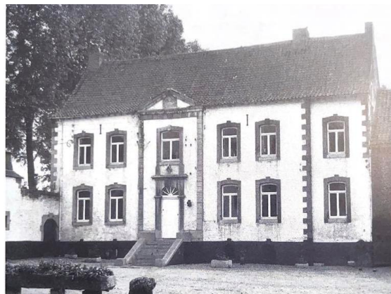
Figure 2: corps de logis d'une ferme en carré, en brique blanchies et calcaire à Ligny. Etat en 1979. Le patrimoine monumental de la Belgique. Tome 18.1, p. 332.
