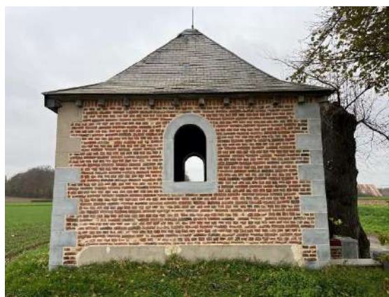
Figure 68: façade latérale droite. Louise Schröder, 1er décembre 2022.
