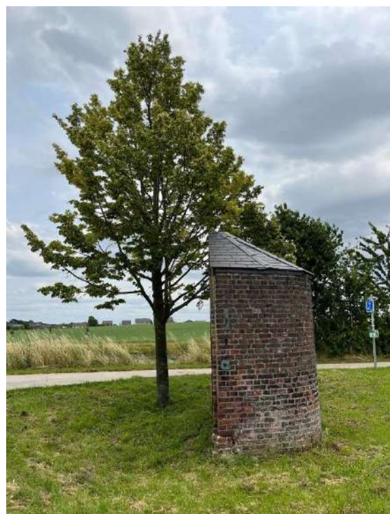
Figure 20: profil de la chapelle, où on remarque son plan en abside. Louise Schröder, 4 juillet 2023.
