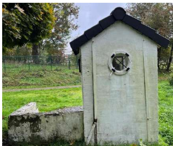
Figure 106: arrière de la fontaine. On distingue les ancrs des tirants ainsi que l'oculus grillagé. Louise Schröder, 18 octobre 2022.
