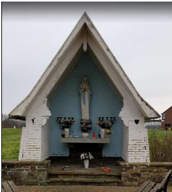
Figure 122: état de la chapelle en 2018. Google Earth, 2023.
