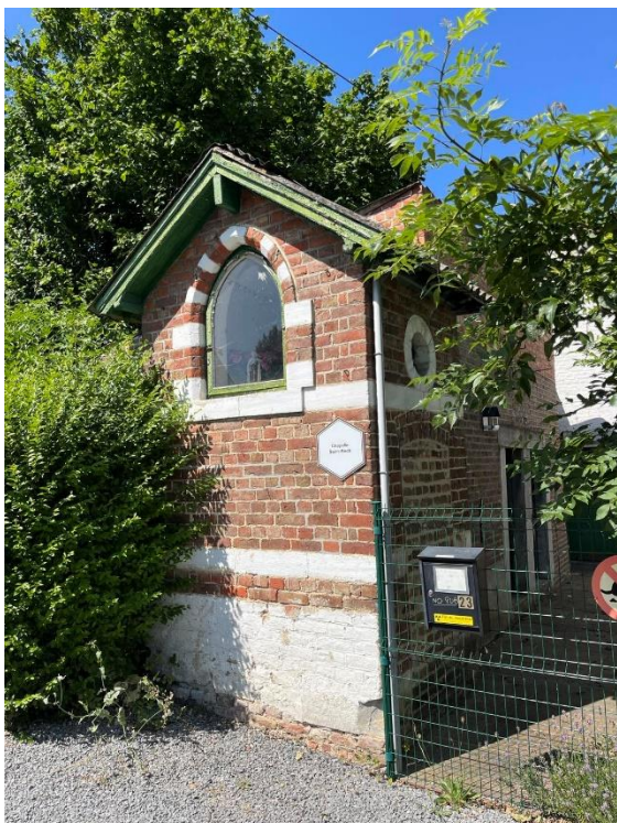
Figure 13: façade avant de la chapelle Saint Roch. On distingue sur la façade droite la porte donnant au puit. Louise Schröder, 13 juillet 2023.
