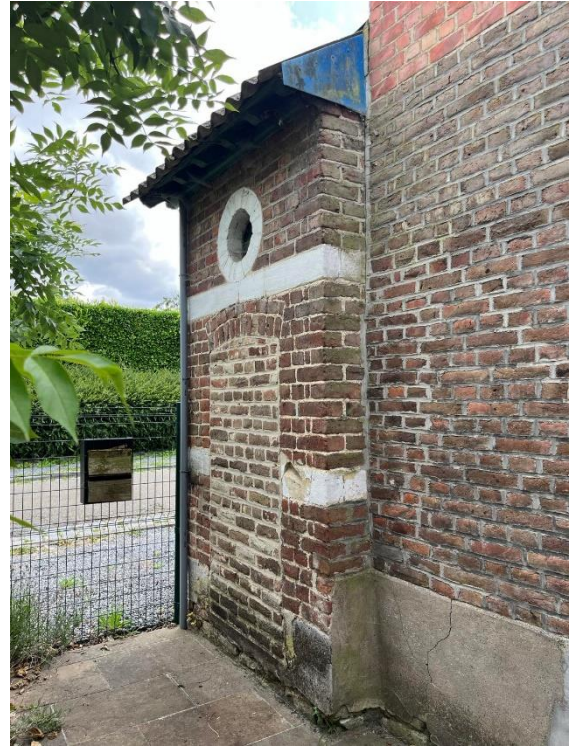
Figure 14: la chapelle Saint Roch (Celles). L'ancienne porte d'accès au puit a été murée. Au-dessus, à hauteur de l'oculus, se trouve la niche qui donne sur la rue. Louise Schröder, 13 juillet 2023.
