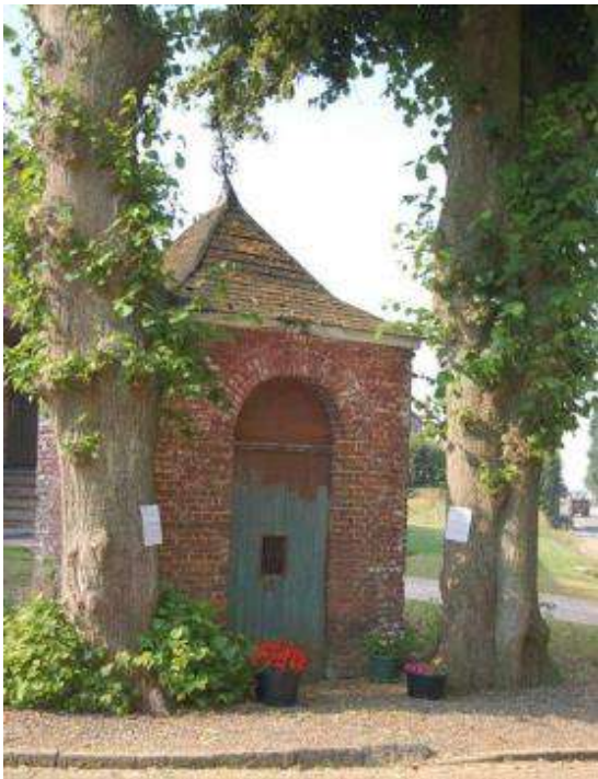
Figure 15: état de la chapelle à une date postérieure inconnue. On y voit une toiture à coyaux. Commune de Faimés, 2023.
