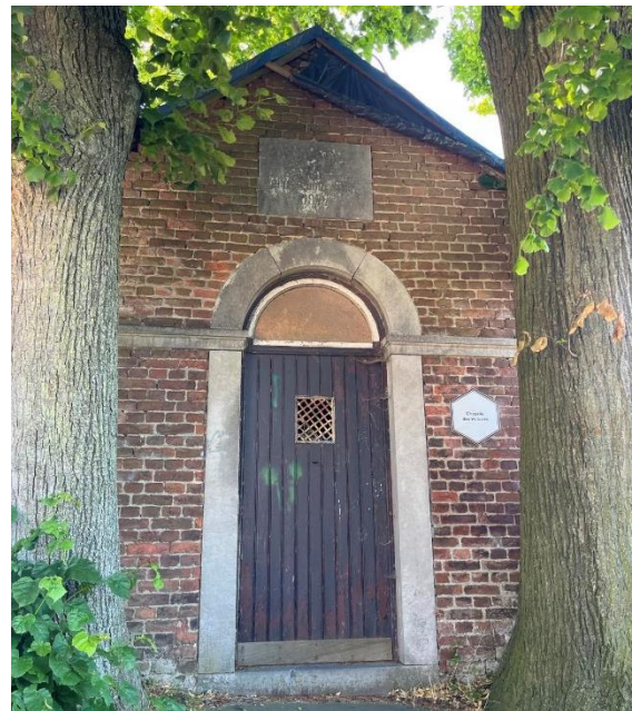
Figure 13 : chapelle des Victoires (Celles). L'arc cintré et les corniches symétriques indiquent une inspiration classique. Louise Schröder, 7 juillet 2023.
