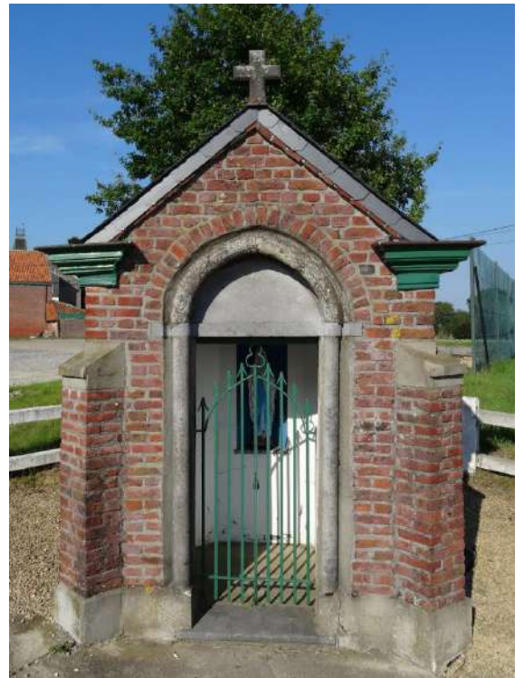
Figure 128: état en 2014. Les corniches et la grille sont vertes. Google earth, juillet 2023.
