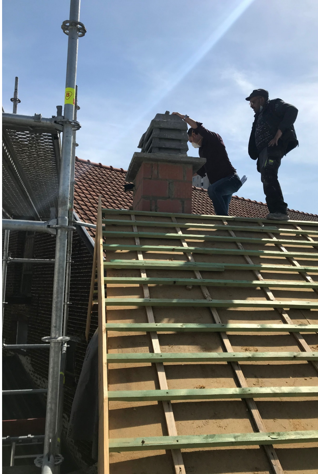
fig. 33 Mise en place des cheminées d'évacuation de la ventilation naturelle (Karbon'architecture et urbanisme)
