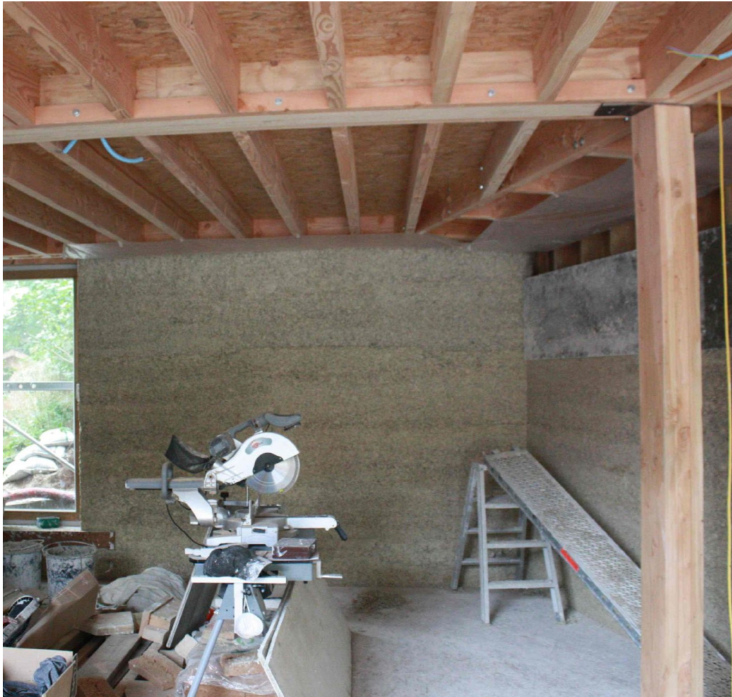
fig. 13 Mise en œuvre du béton de chanvre banché (Karbon'architecture et urbanisme)
