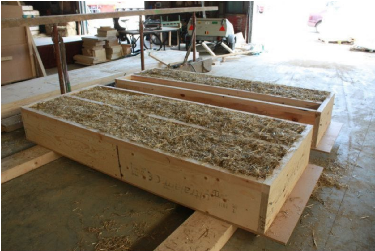
fig. 14 Réalisation des modules préfabriqués en ossature bois, isolés en paille, pour les 2 ème et 3 ème étages (Karbon'architecture et urbanisme)
