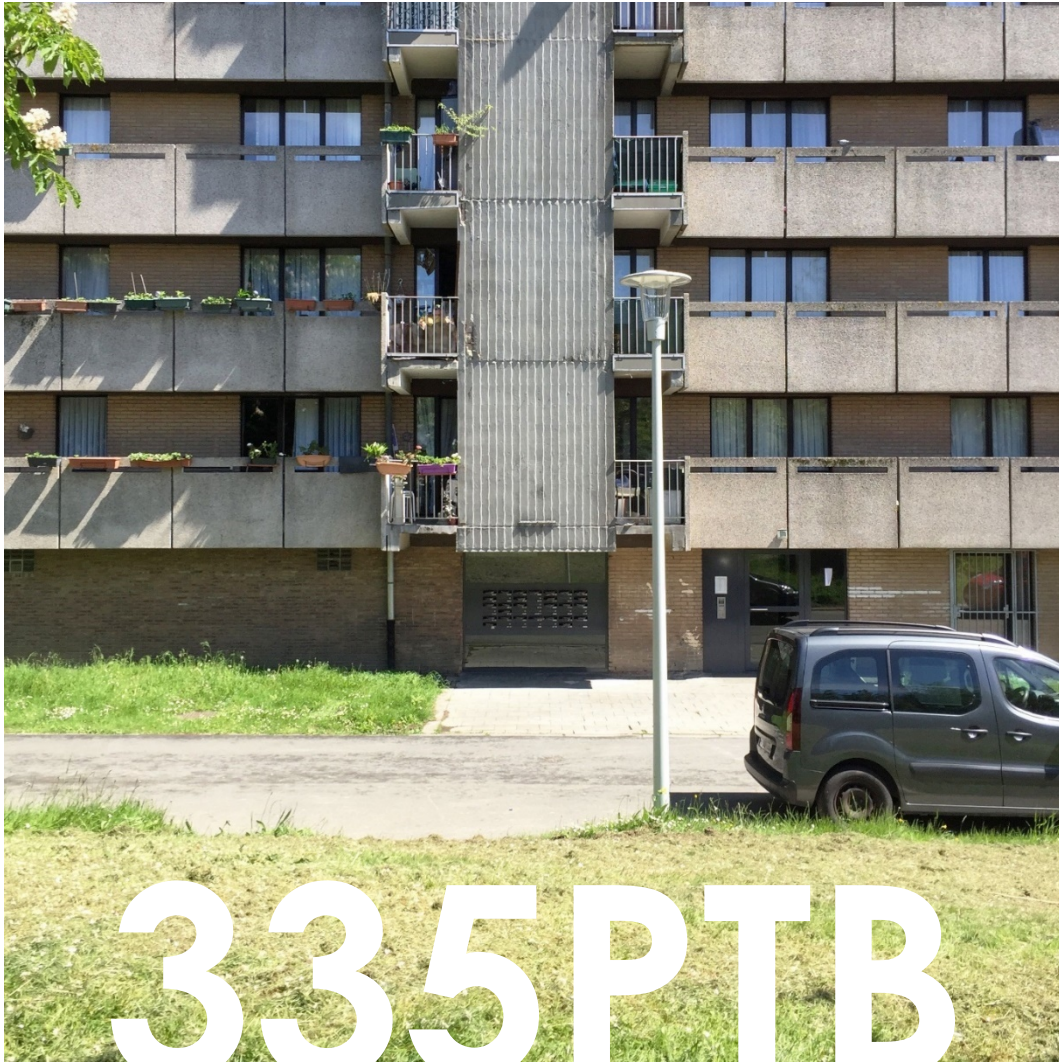
fig. 34 Façade d'une des tours Peterbos (Karbon'architecture et urbanisme)
