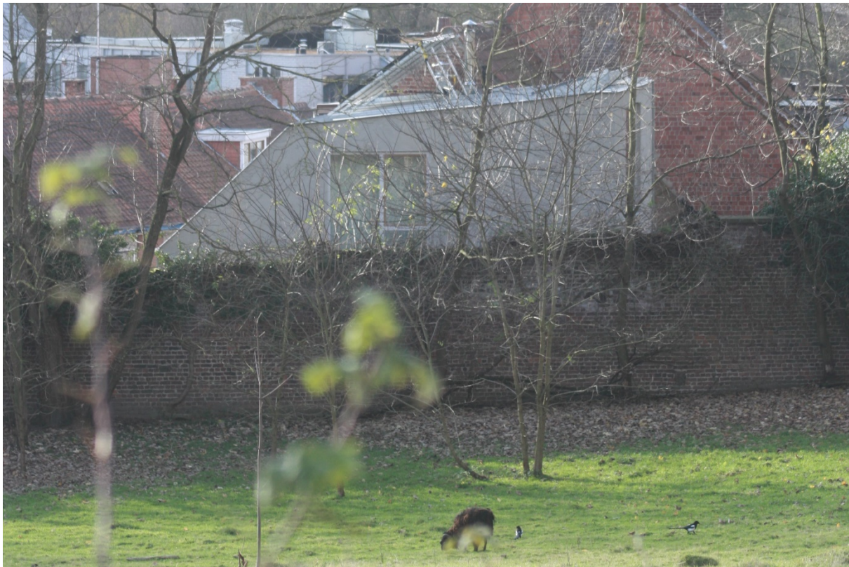
fig. 4 Vue de la maison depuis le plateau d'Avjil (Karbon'architecture et urbanisme)
