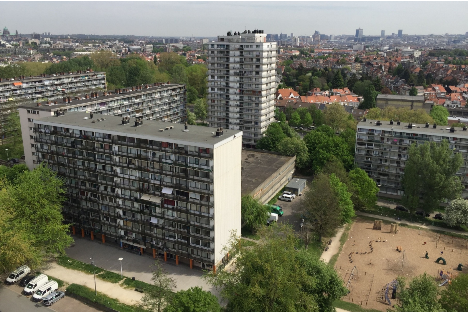
fig. 35 Vue aérienne de l'ensemble Peterbos (Karbon'architecture et urbanisme)
