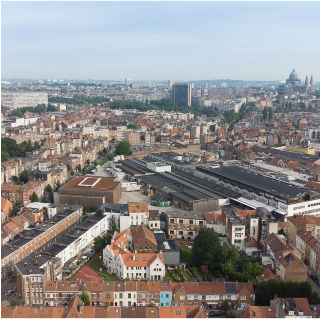
fig. 16 Vue aérienne de l'ensemble Van Meulecom en intérieur d'îlot (Marc Detijff)
