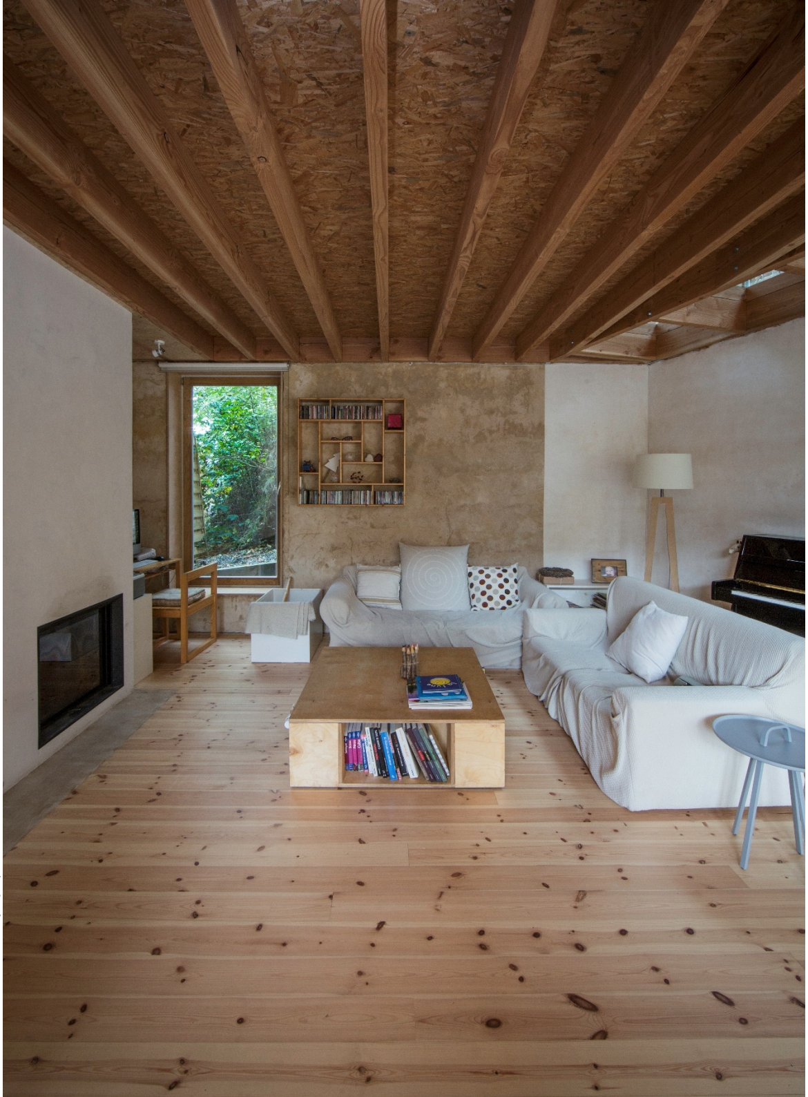
fig. 10 Vue du salon où les murs ont été recouverts d'un enduit à base d'argile et de chaux (Serge Anton)
