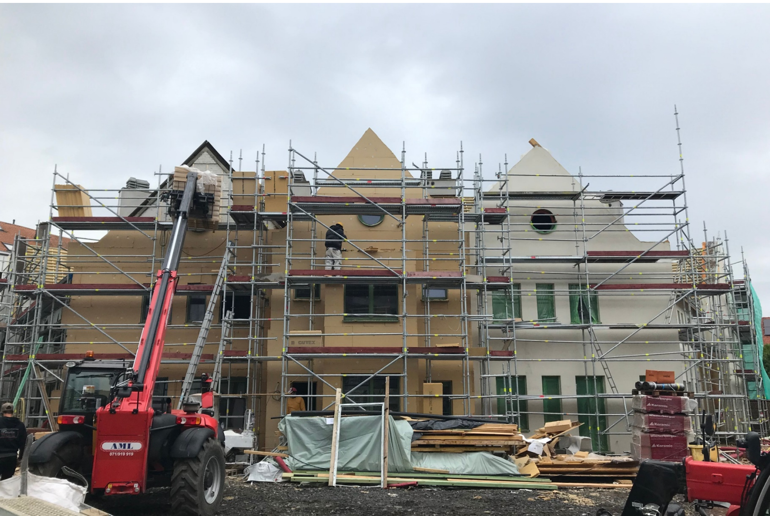
fig. 24 Mise en place de l'isolant et de l'enduits de finition à base de chaux (Karbon'architecture et urbanisme)
