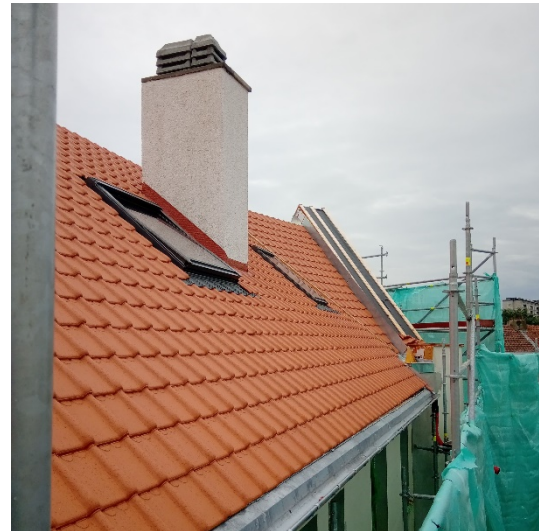
fig. 28 Couverture de la toiture (Karbon'architecture et urbanisme)
