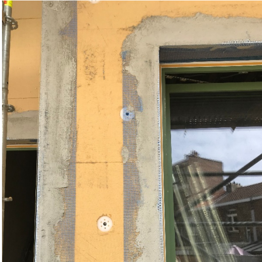
fig. 27 Rejointoyage entre les panneaux de fibre de bois (Karbon'architecture et urbanisme)
