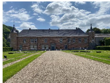
Fig. n°70 : Façade Nord du château. Photo prise par DETHIER M. Mai 2023.
