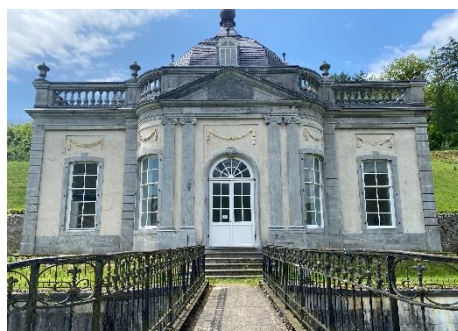
Fig. n°72 : Pavillon 'Frédéric Salle'. Photo prise par DETHIER M. Mai 2023.
