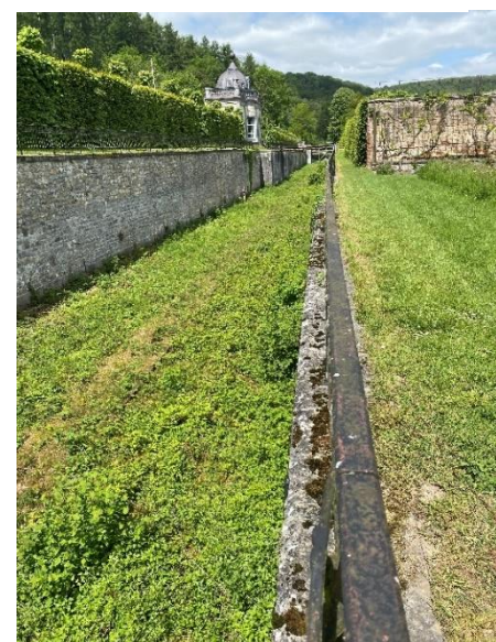
Fig. n°76 : Chemin de halage traversant le domaine. Photo prise par DETHIER M. Mai 2023.
