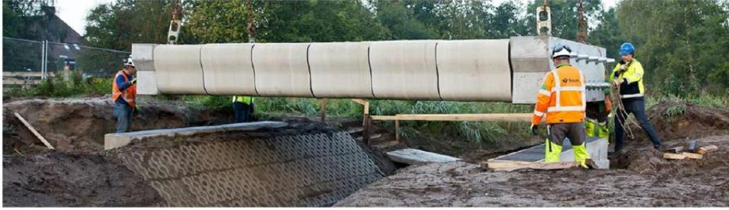
FIGURE 2.14 – Passerelle avec tendons aux Pays Bas [ASPRONE et al. 2018]
