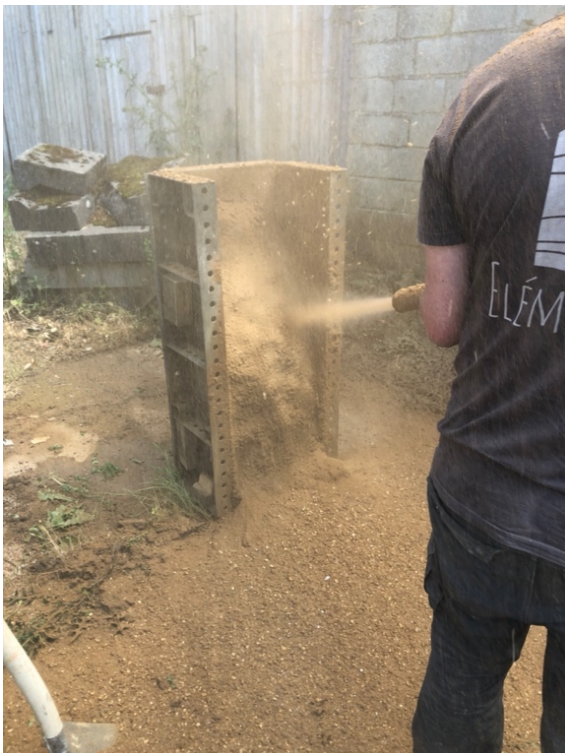
Figure 3.25 : Projection avec beaucoup de rebond
