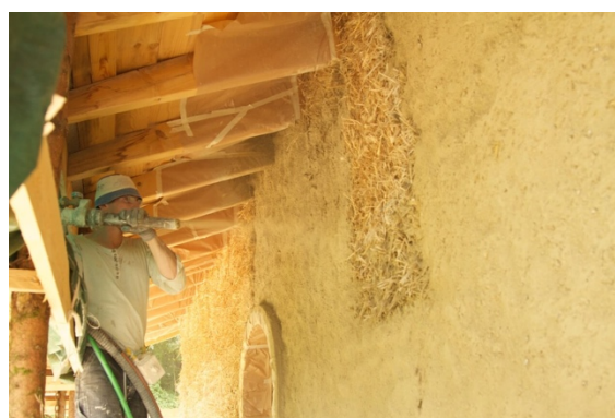
Figure 2.27 : Projection sur mur en paille pour finition
