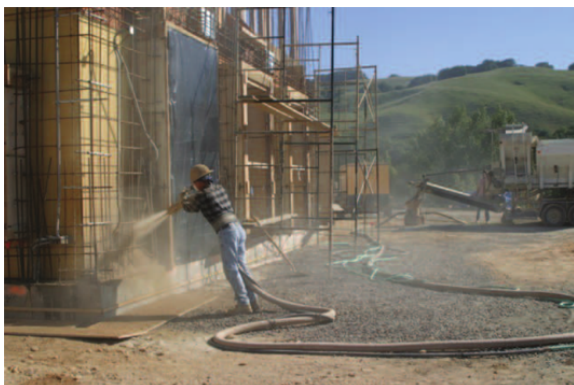
Figure 2.24 : Projection de terre
