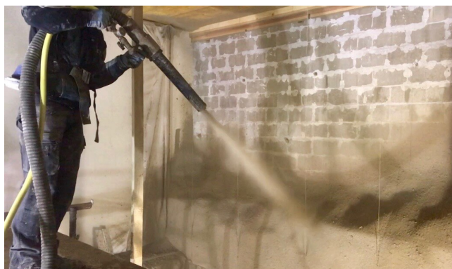
Figure 2.26 : Projection contre mur pour un bouteiller
