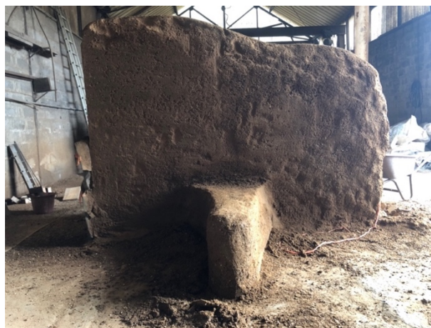
Figure 3.35 : Voile et banc terminés
