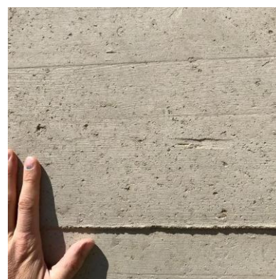
Figure 2.30 : Aspect du mur brut coté décoffré
