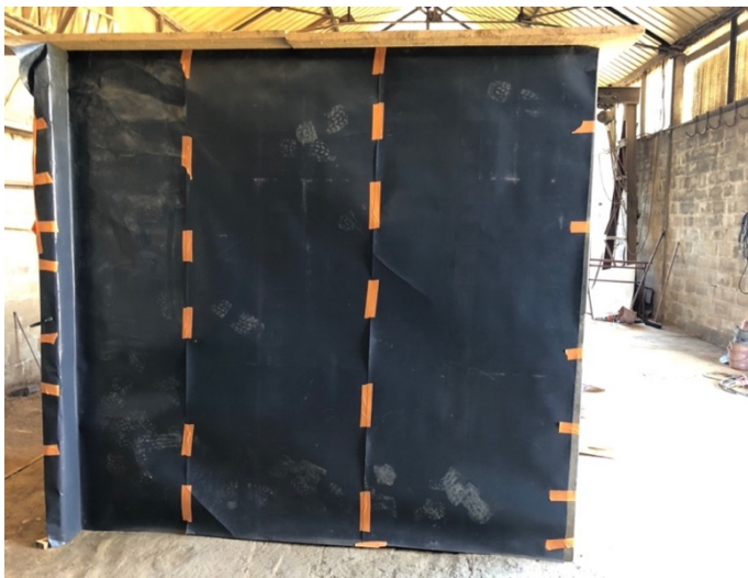
Figure 3.32 : Coffrage avec carton de désolidarisation
