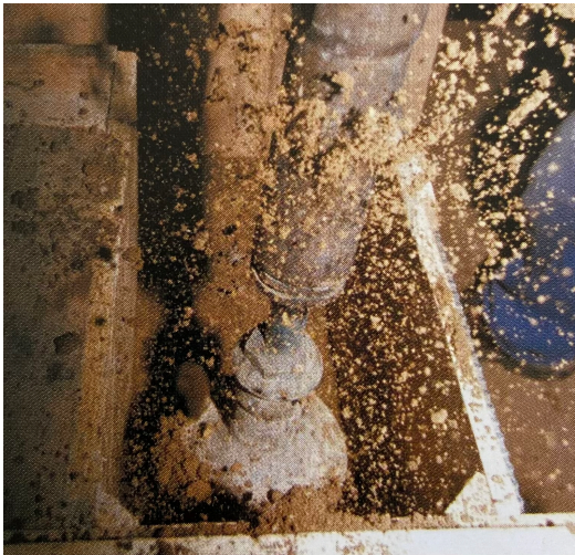
Figure 2.13 : Fouloir pneumatique en action
