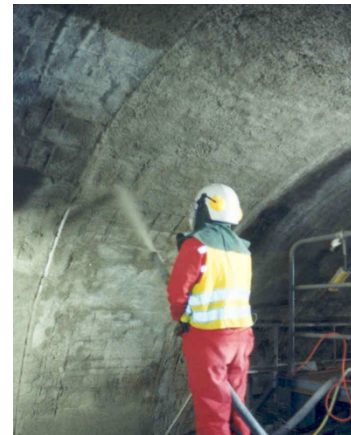
Figure 2.23 : Projection par voie sèche (réparation du tunnel sous la Manche 2006)
