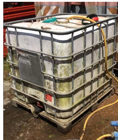
Figure 3.22 : Réserve d'eau de pluie
