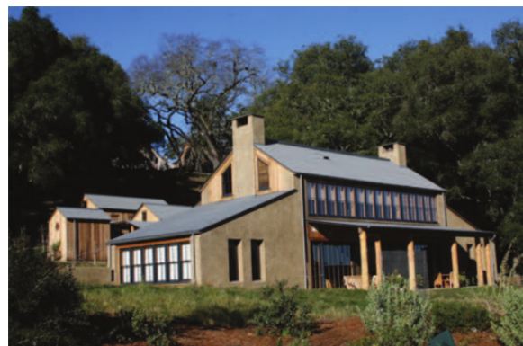
Figure 2.25 : Résultat final voile projeté
