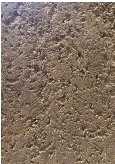
Figure 3.39 : Face coupée (façonnage)
