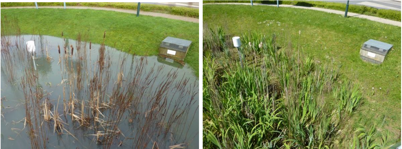
FIGURE 1.5 – Bassin qui se vidange par infiltration pour les petites pluies puis par rejet à débit régulé lorsque la hauteur d'eau dépasse 30 cm (Ledun et al. , 2018).
