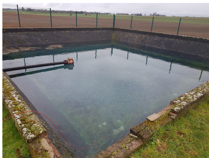
FIGURE 3.3 – Bassin d'infiltration de la CILE à Kemexhe, Crisnée.
