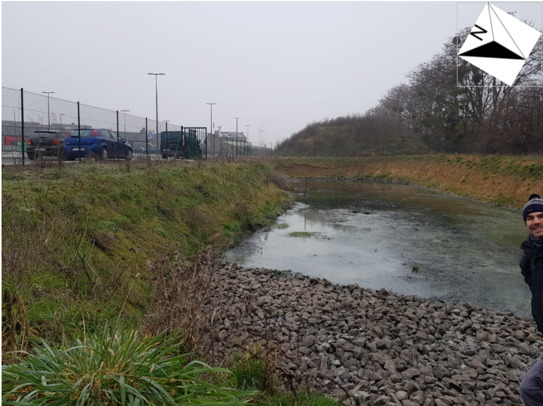
FIGURE 7 – Même vue que sur la Figure 6 mais depuis le fond du bassin, au niveau de la bouche d'alimentation.
