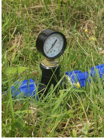
(a) Manomètre placé en entrée d'une bande perforée utilisé pour l'expérimentation en Belgique.
