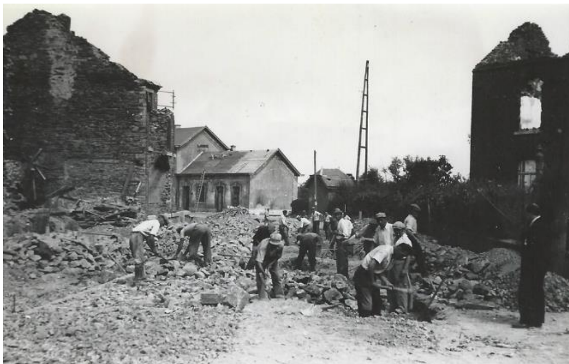
Figure 41 : Réparation de la voirie par des ouvriers belges, Bastogne, s.d. (après la Bataille des Ardennes). © Coll. Jacques Degives
