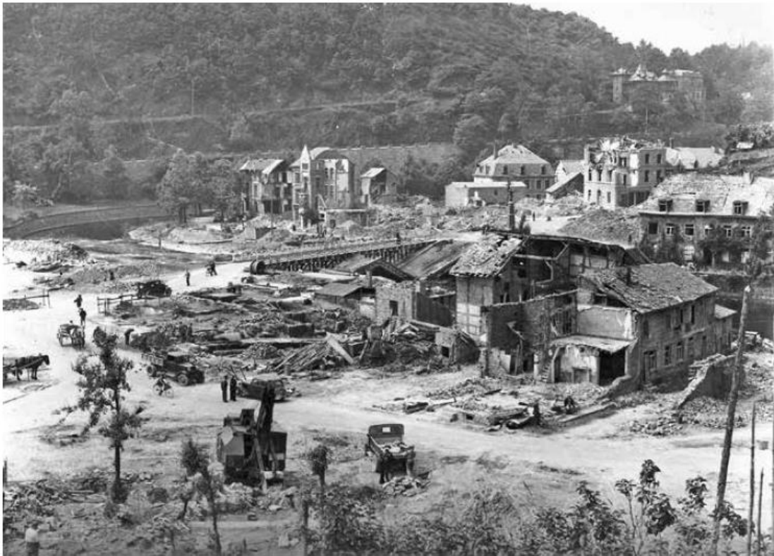
Figure 45 : Déblaiement des ruines, La Roche-en-Ardenne, 1945. © Coll. Jean-Michel Bodelet
