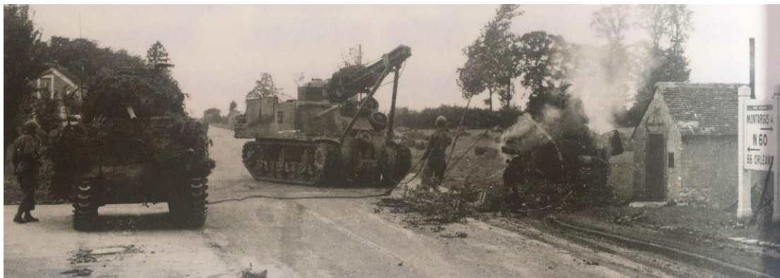
Figure 36 : Les troupes du Génie américain utilisent un char de dépannage sur châssis M3 pour déblayer la route en enlevant une épave d'un autre char, Montargis, France, août 1944. © NARA
