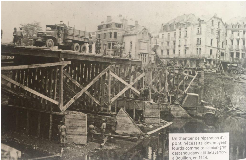
Figure 51 : Chantier de réparation du pont de Bouillon passant par-dessus le lit de la Semois par le Génie américain en 1944. © NARA
