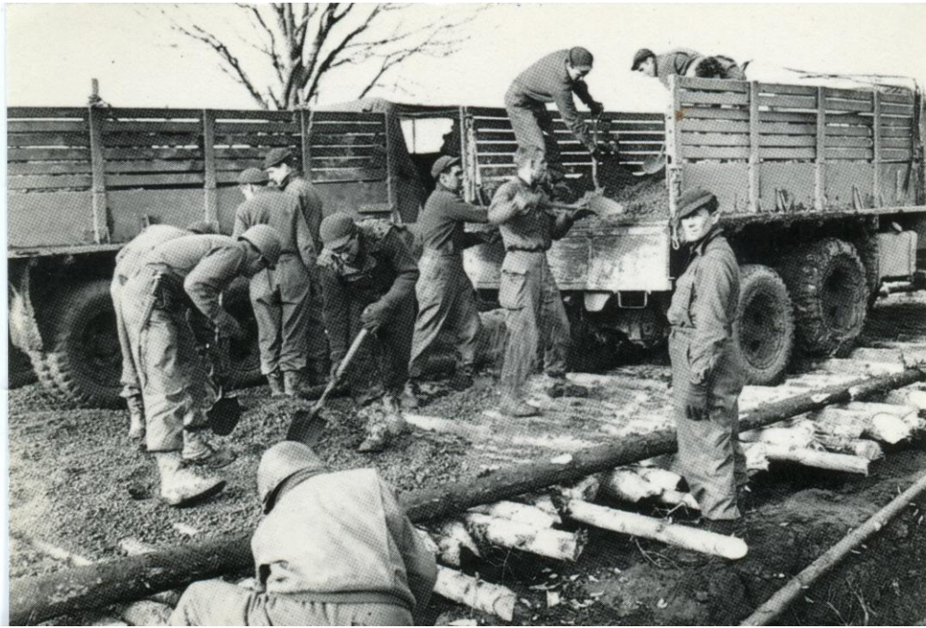
Figure 54 : Réfection des routes détruite par les membres du Génie de l'armée américaine, Bataille des Ardennes, 1944-1945. © Coll. Bastogne War Museum
