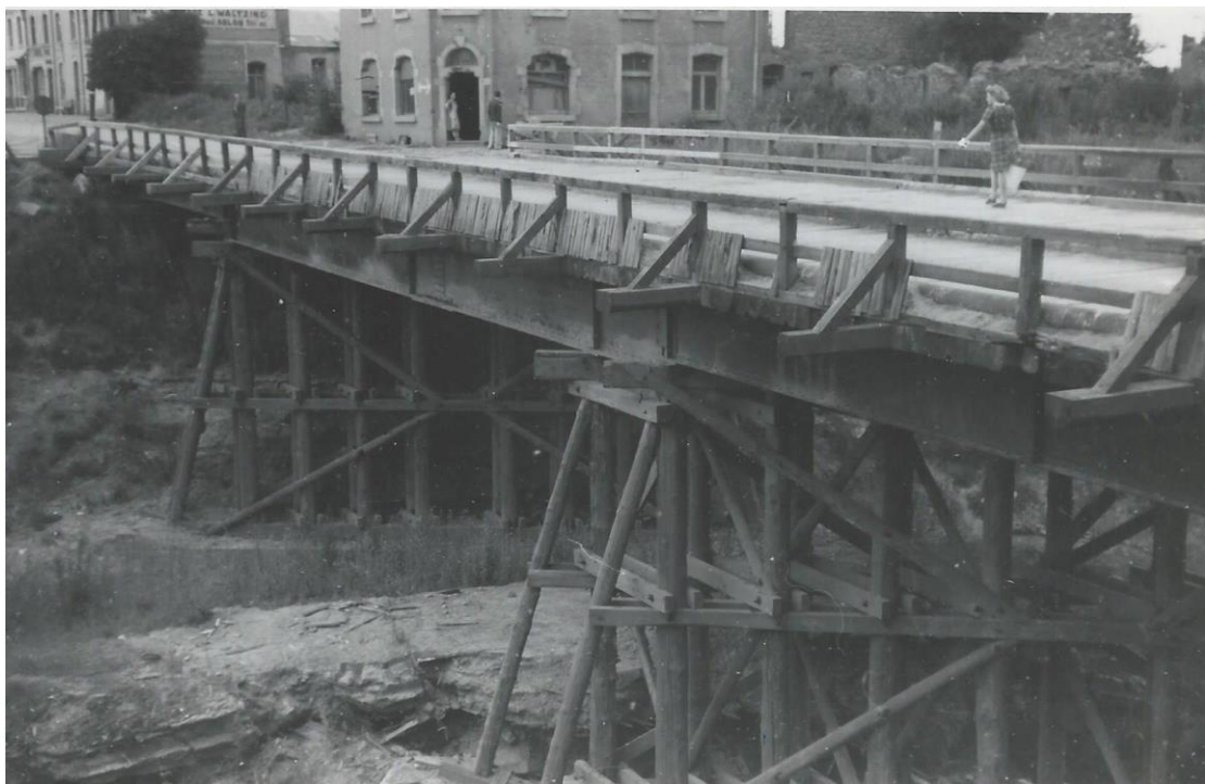
Figure 53 : Pont provisoire en bois, Bastogne, s.d. © Coll. Jacques Degives
