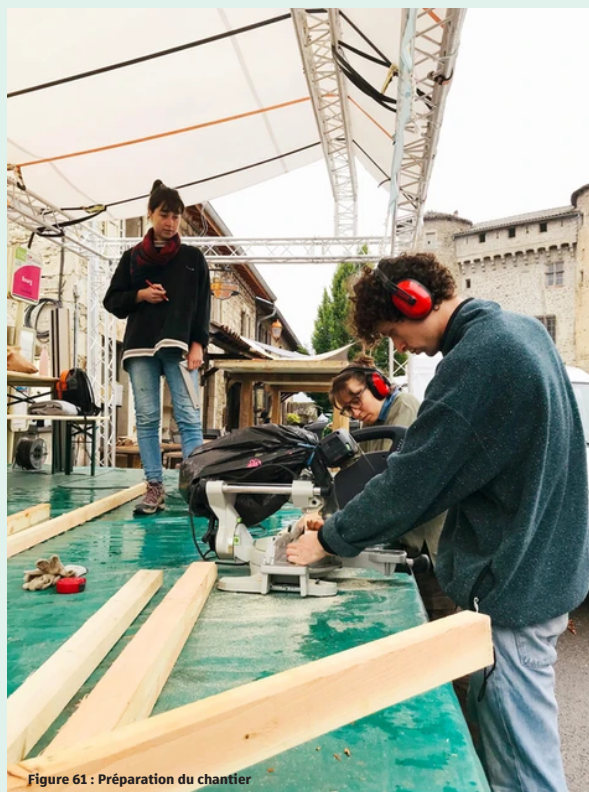
Figure 61 : Préparation du chantier
