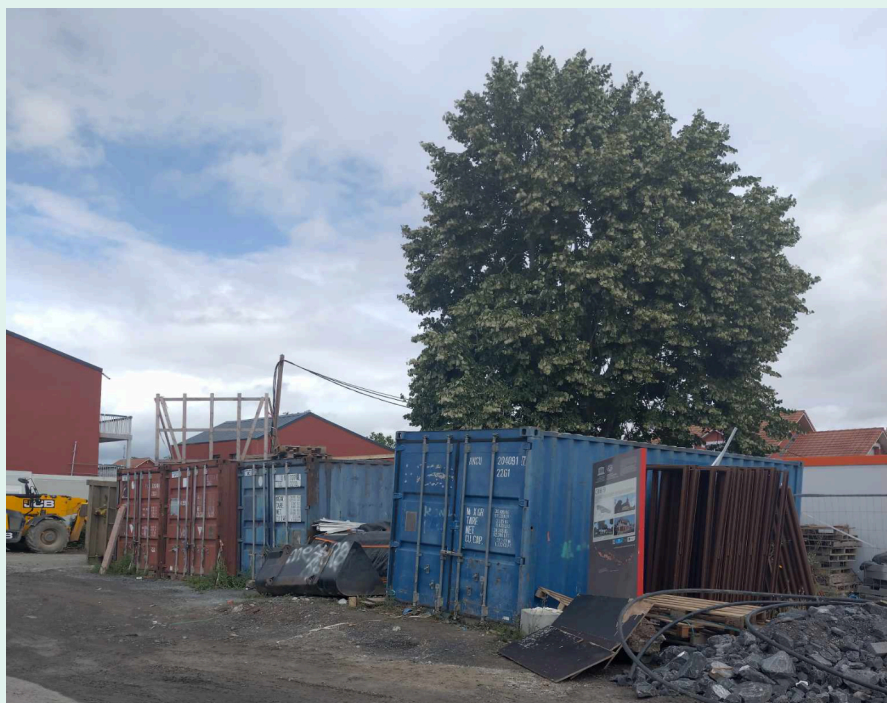
Figure 43 : Les travaux aujourd'hui sur la placette rond-point
