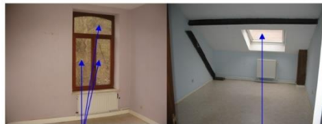
On prend en compte 1/14 superficie des parties vitrées en cas vitrage vertical
