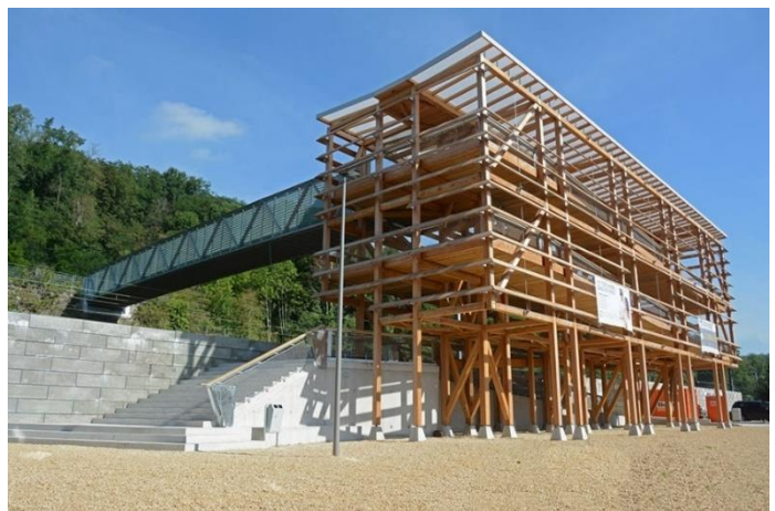
Figure 22 : Passerelle cyclo-pédestre place Vivegnis. (Ville de Liège, s.d)
