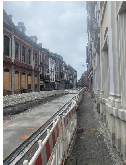
Figure 45 : La rue Féronstrée en travaux. (Eglantina Durguti, 2023)
