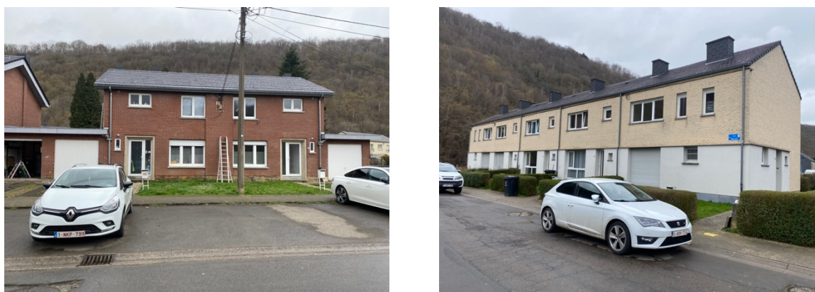
Figure 14 : Bâtiments résidentiels du quartier de Fraipont
