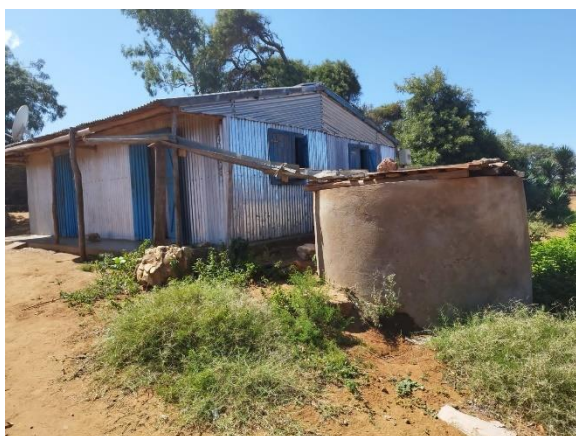
Illustration 1 : Bassin individuel de captage d'eau de pluie
