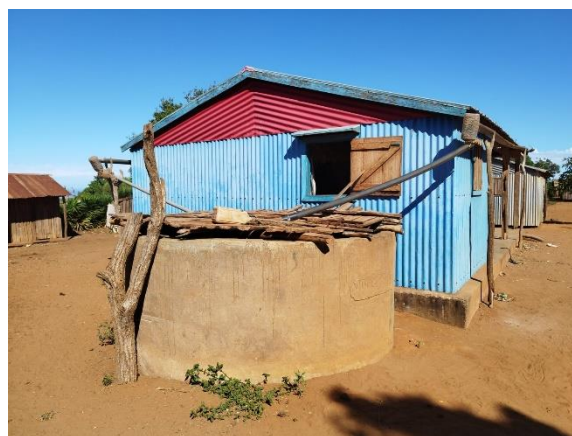
Illustration 1 : Bassin individuel de captage d'eau de pluie
